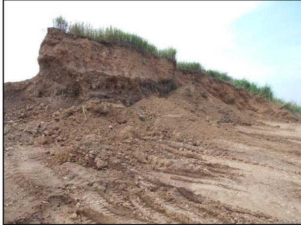
**Note:** presenza di materiale di diversa granulometria. Lungo la duna è stata rilevata l'assenza di materiale per circa 30/40 m di lunghezza, riutilizzato; in tal modo è stato possibile verificare che il suolo accantonato presenta un buon grado di compattazione. La duna è parzialmente sfalciata e, nella parte Nord-Ovest, ha un'altezza minore fino ad arrivare a un'altezza di 3-4 m.
