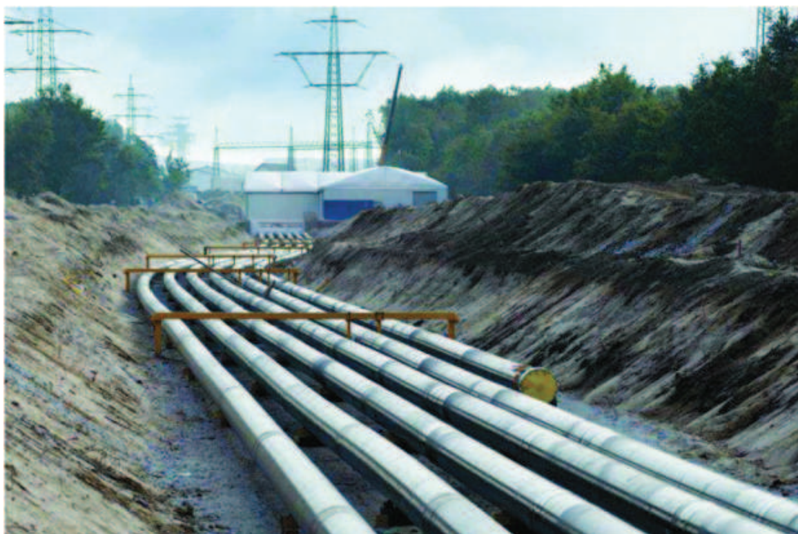
Figura. 1: Sistema GIL nel processo di installazione [2].
