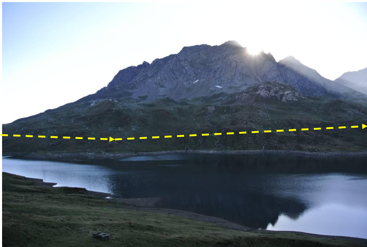
Figura 16 – area da sost. 4 a sost. 6; la linea tratteggiata rappresenta l'andamento indicativo dell'asse dell'elettrodotto, la freccia indica la direzione dell'elettrodotto ( dal sost. 1B al sost. 19)
