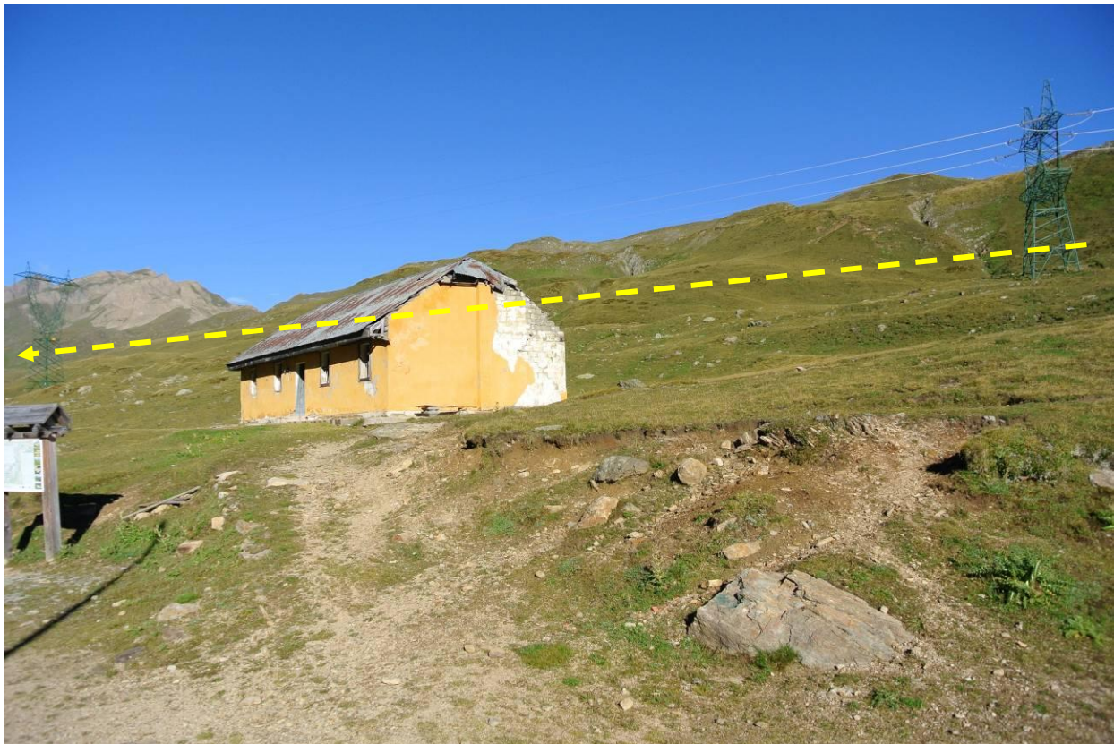
Figura 24 – area campata sost. 1 – sost. 2; la linea tratteggiata rappresenta l'andamento indicativo dell'asse dell'elettrodotto, la freccia indica la direzione dell'elettrodotto ( dal sost. 1 al sost. 29)
