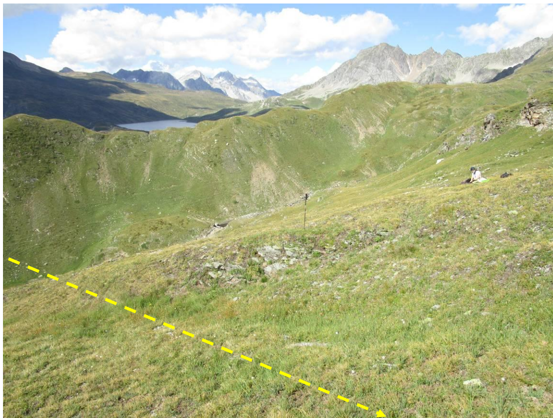
Figura 34 – area sost. 25 – sost. 26; la linea tratteggiata rappresenta l'andamento indicativo dell'asse dell'elettrodotto, la freccia indica la direzione dell'elettrodotto ( dal sost. 1 al sost. 29)
