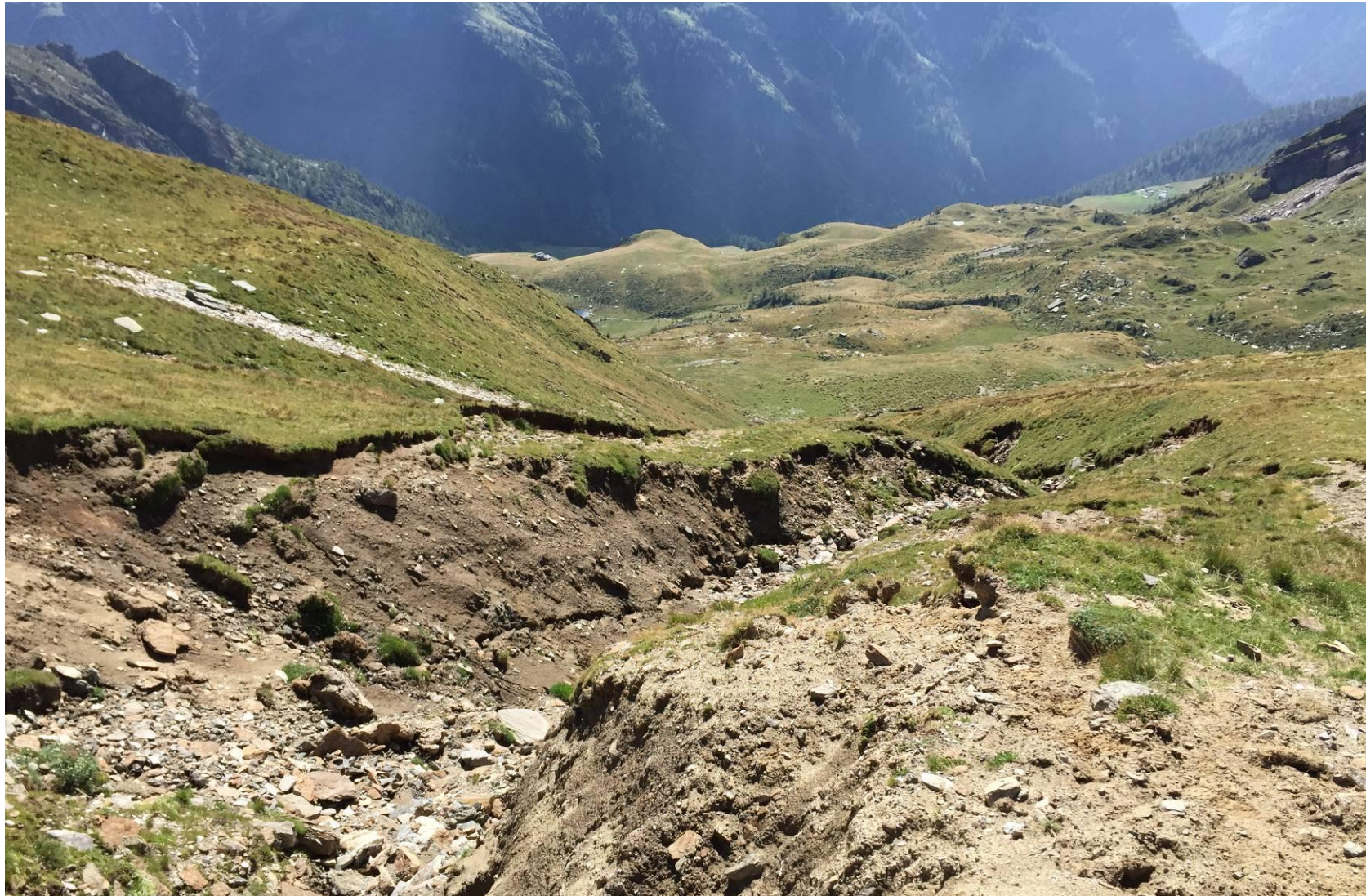
Figura 50. Solco erosivo localizzato in corrispondenza di un impluvio a nord rispetto al sostegno 77
