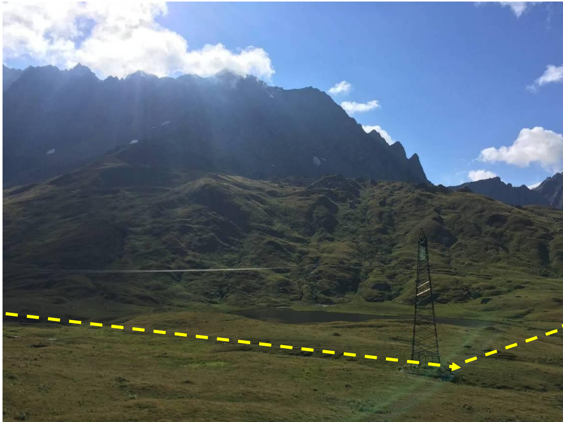
Figura 13 – area nei pressi del sost. di vertice 2B; la linea tratteggiata rappresenta l'andamento indicativo dell'asse dell'elettrodotto, la freccia indica la direzione dell'elettrodotto ( dal sost. 1B al sost. 19)
