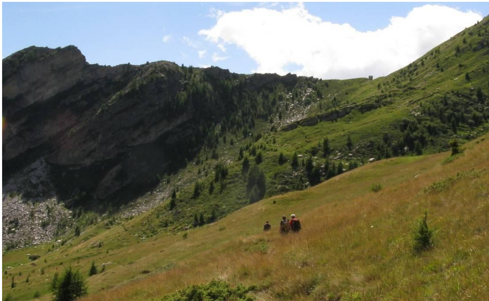
Figura 46. Area a valle del sostegno 77
