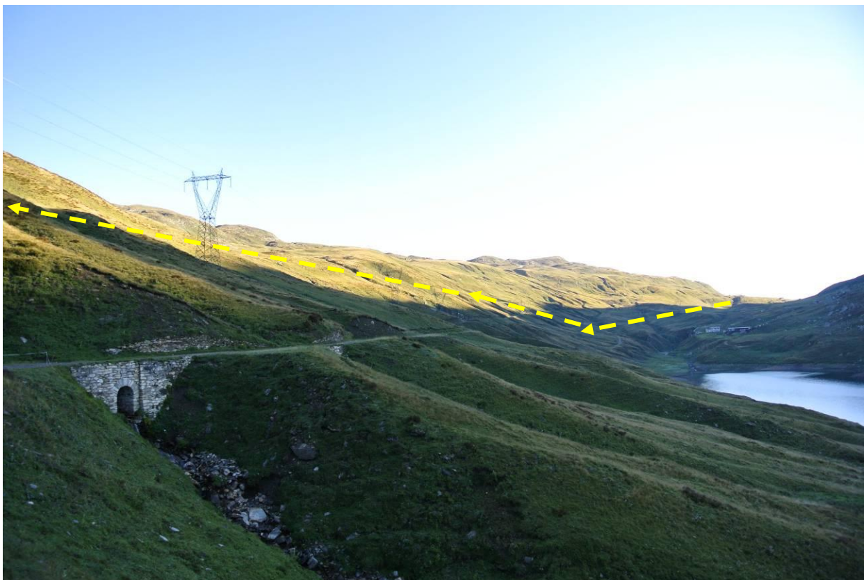
Figura 28 – area sost. 1 – sost. 12; la linea tratteggiata rappresenta l'andamento indicativo dell'asse dell'elettrodotto, la freccia indica la direzione dell'elettrodotto ( dal sost. 1 al sost. 29)
