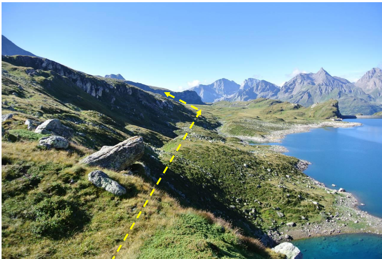
Figura 18 – area da sost. 7 a sost.10; la linea tratteggiata rappresenta l'andamento indicativo dell'asse dell'elettrodotto, la freccia indica la direzione dell'elettrodotto ( dal sost. 1B al sost. 19)
