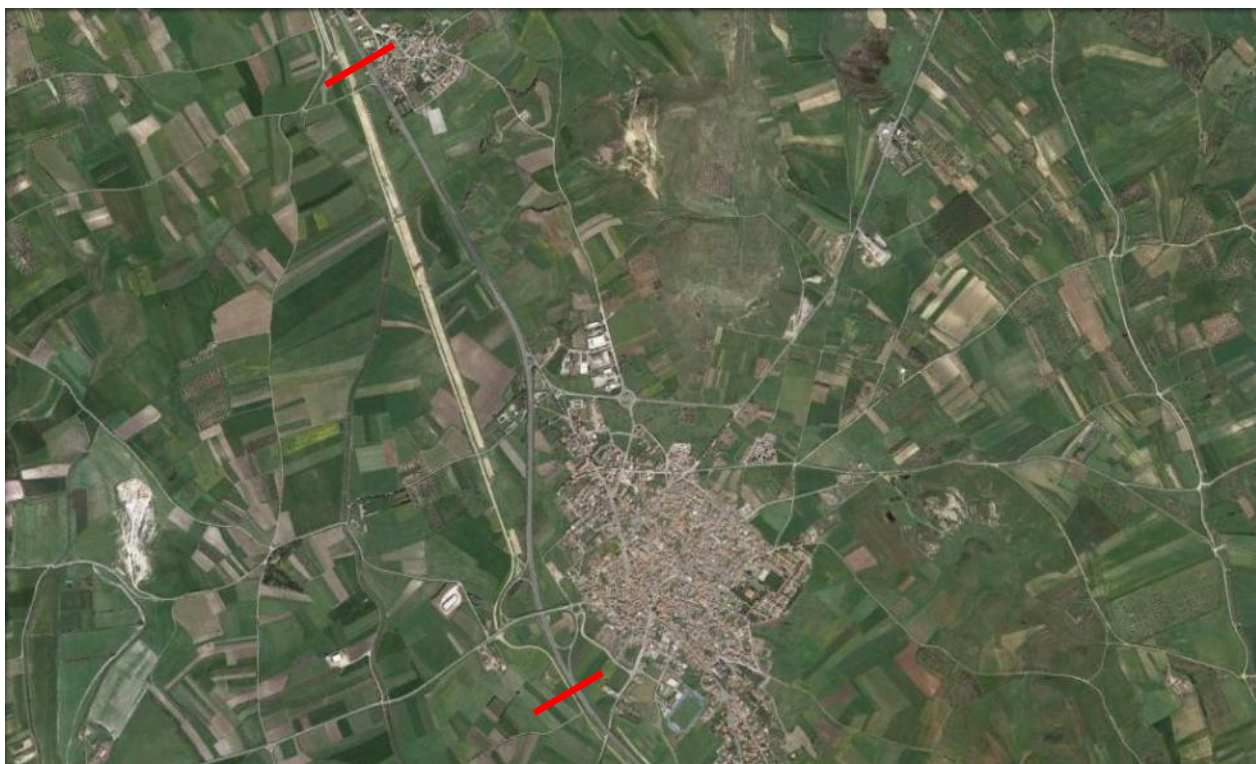
Tratto oggetto d'intervento tra l'abitato di Nuramins e la frazione di Villagreca
