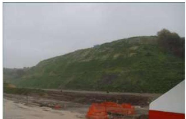
Nei casi in cui le scarpate, per le caratteristiche geolitologiche o per la morfologia acclive, non dessero sufficienti garanzie di inerbimento mediante i sistemi di semina tradizionali, si sono previsti interventi di idrosemina di sementi di piante erbacee perenni a radicazione profonda, utilizzate per il contrasto dell'erosione, la rinaturalizzazione, la conservazione del suolo, e la protezione di opere infrastrutturali.
