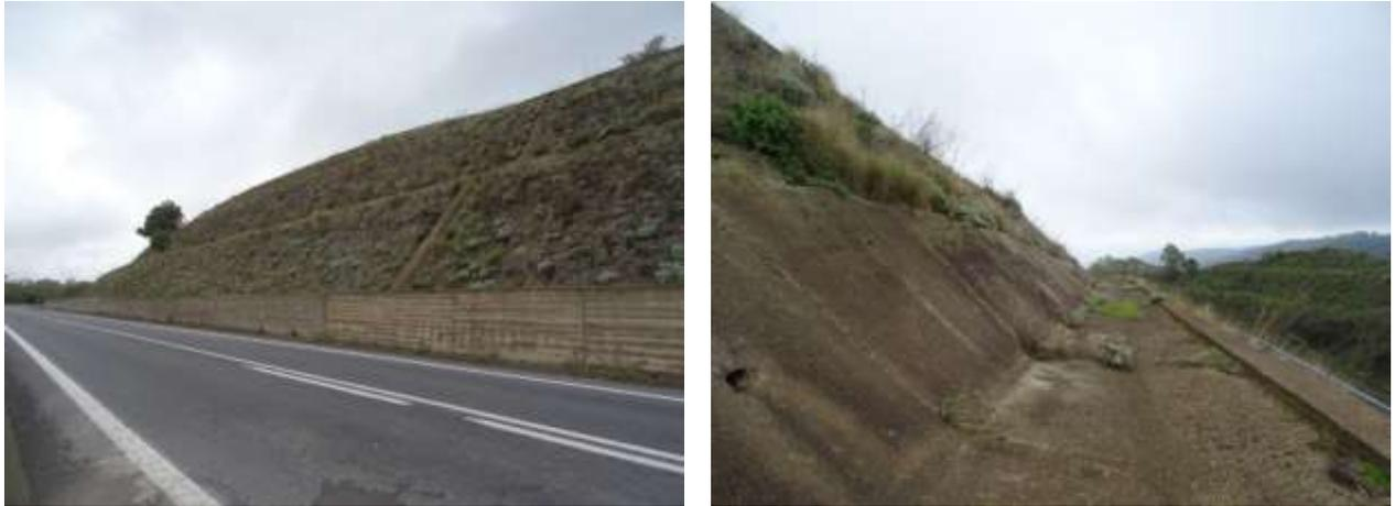
**Figura 25: degli interventi di Soil nailing previsti nel Lotto 6 al km 4+700 – 5+100 circa; sez tipologica e vedute esemplificative della resa estetica durante i lavori e dopo l'attecchimento della vegetazione**
