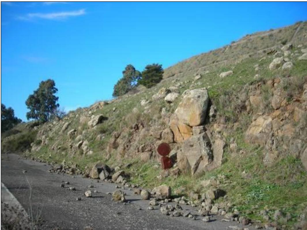
**Foto E.17 – Intercalazione di sabbie e limi carbonatici rilevati presso la trincea esistente della S.S. 514 alla pk. 3+100 del Lotto 5 di progetto.**
