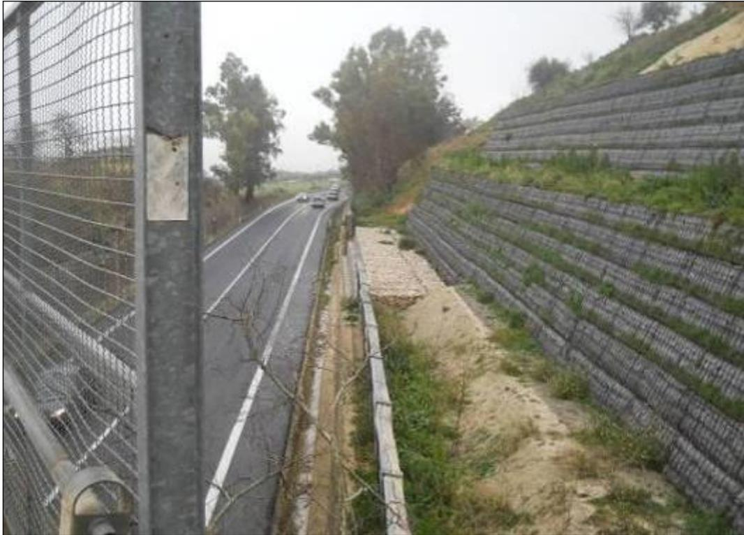
**Foto F.36 – Colamenti (Frana L4\_1) osservabili nell’ambito della viabilità secondaria presso la spalla meridionale del Viadotto Quattro Poggi; tali dissesti hanno determinato la deformazione del manto stradale della strada di collegamento secondaria.**
