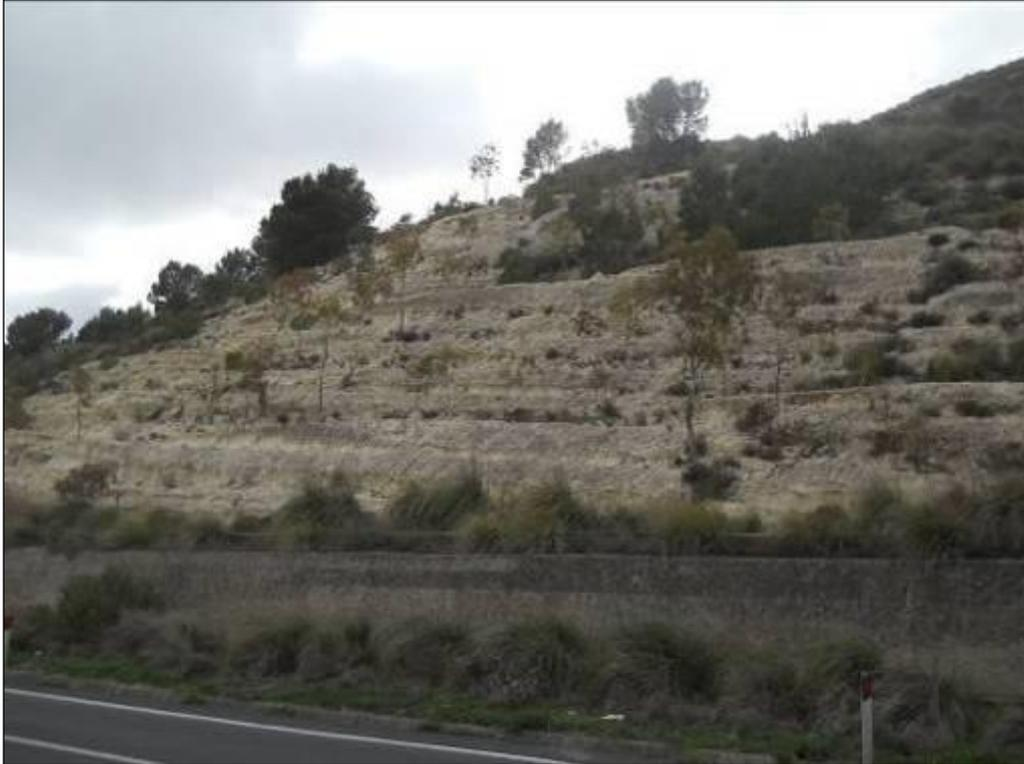
**Foto E.19 – Affioramento della facies marnoso-calcareea della Formazione dei Trubi visibile presso lo scavo di un'area di servizio esistente situata in corrispondenza della pk. 1+850 del Lotto 5 di progetto.**
