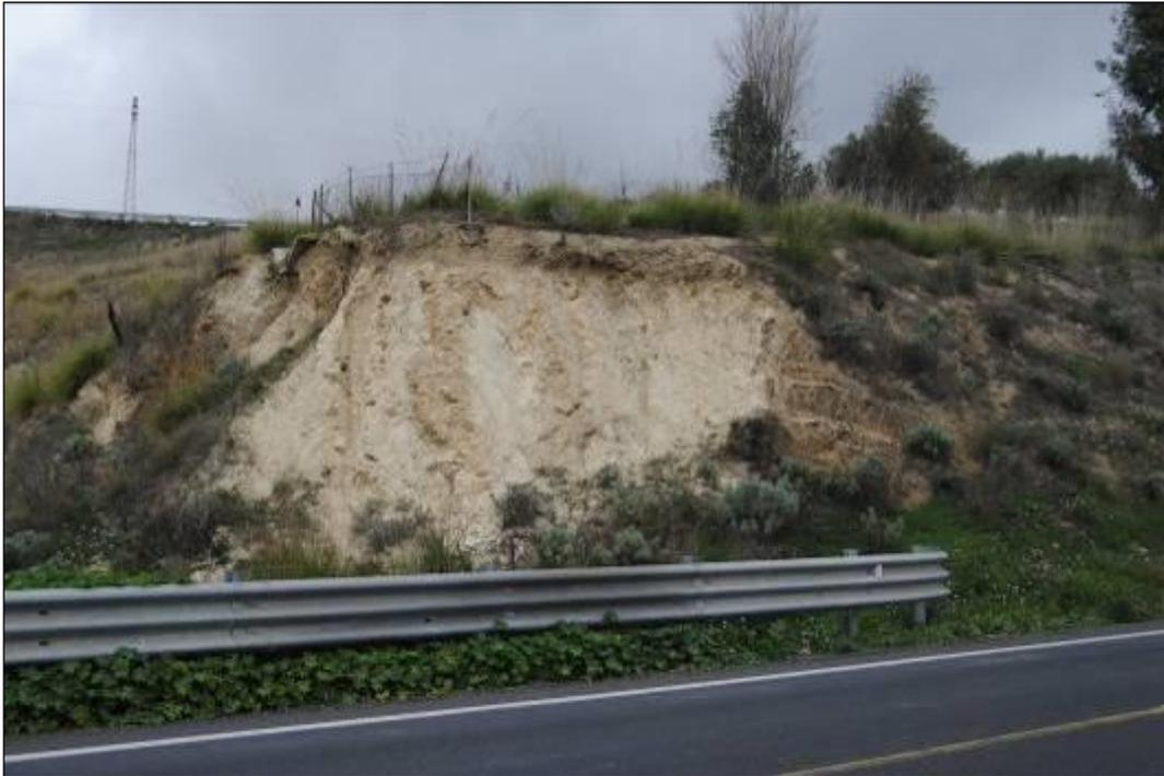
**Foto E.24 – Alternanza di strati calcarenitico-marnosi sub-orizzontali affioranti lungo l'asse destro di progetto alla pk 1+070 del Lotto 4.**
