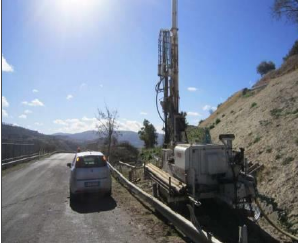
Foto G.5 – Esecuzione del sondaggio S118p equipaggiato con piezometro.
