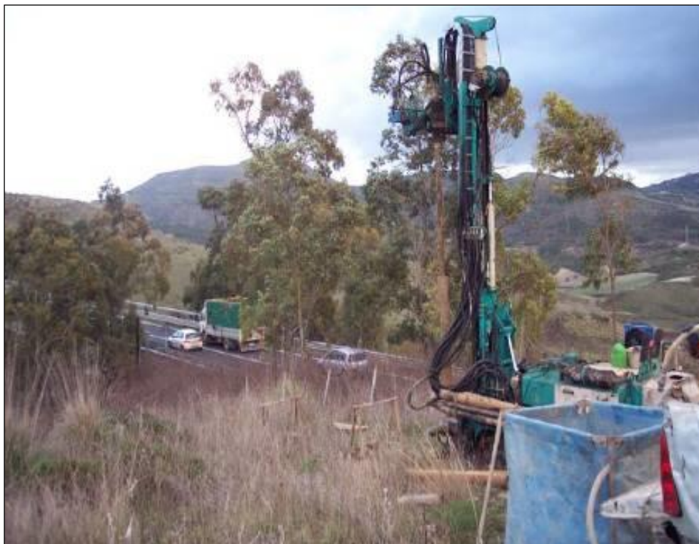
Foto I.4 – Esecuzione del sondaggio S126p.
