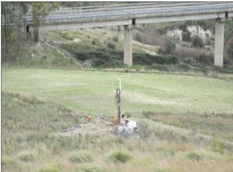
Foto E.4 – Esecuzione sondaggio S102i equipaggiato con inclinometro.
