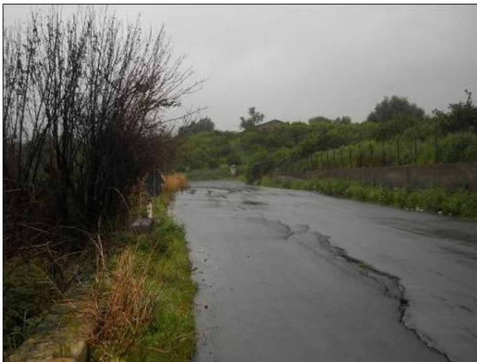
Foto L.4 – Evidenti deformazioni della medesima strada di svincolo.
