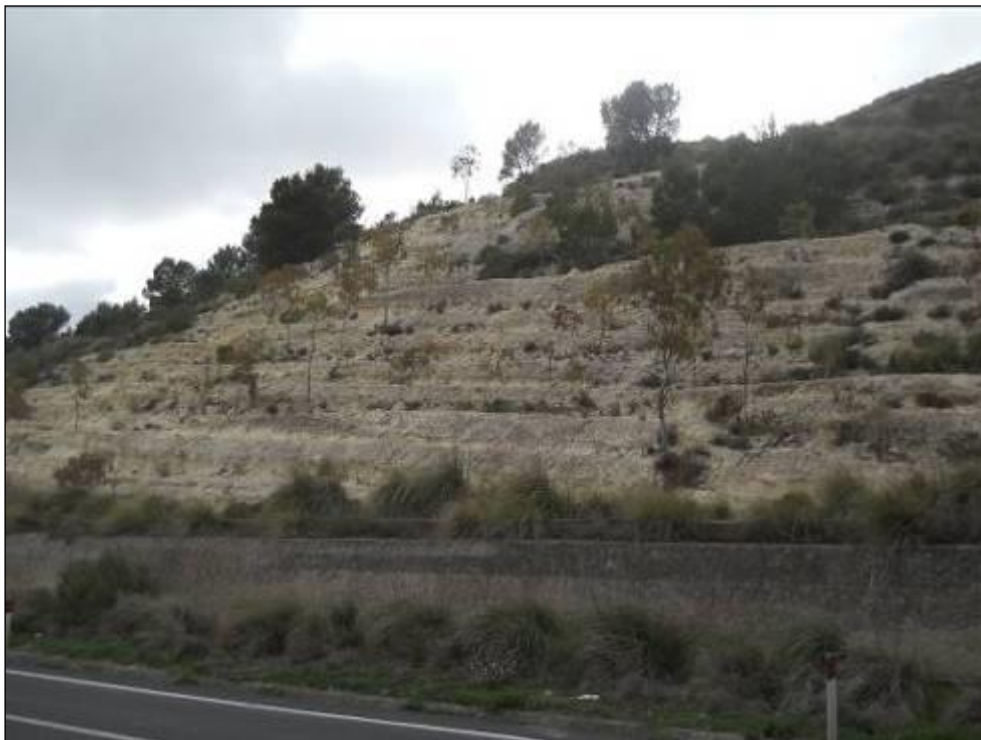
Foto D.2 – Trincea stradale situata nel tratto mediano della zona interessata dalla frana di crollo, in cui si sviluppa l'attuale sede stradale della S.S. 514; visibile la geometria terrazzata dello scavo e l'affioramento delle testate di strato delle marne ed argille attribuibili alla Formazione dei Trubi.
