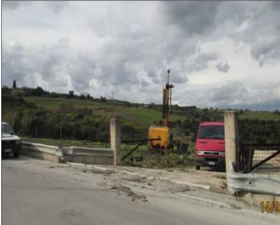
Foto L.5 – Esecuzione sondaggi S186i equipaggiato con inclinometro.
