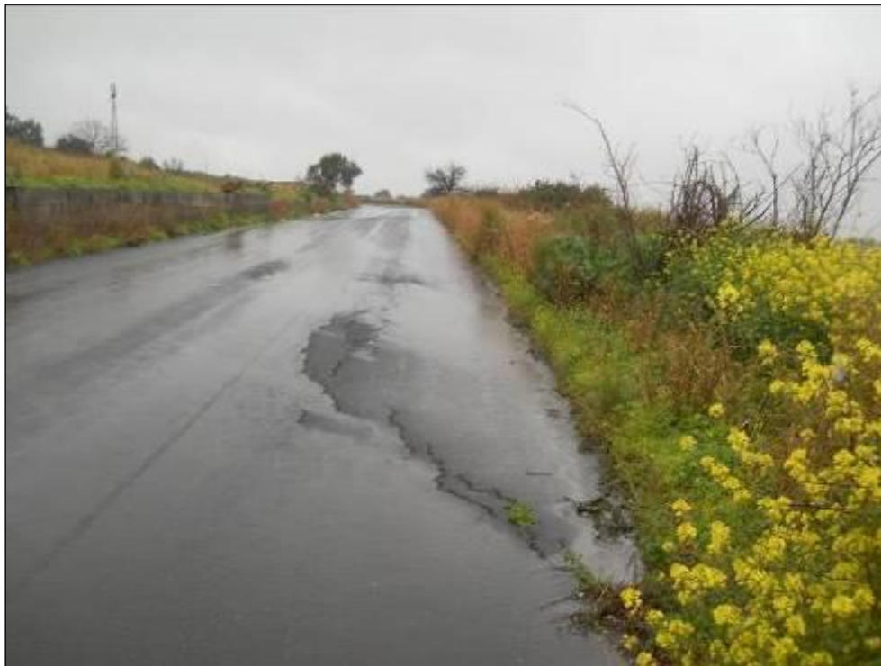
Foto L.4 – Evidenti deformazioni della medesima strada di svincolo.
