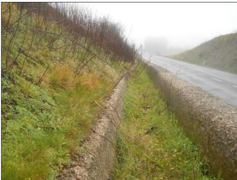
Foto K.4 – Fosso di guardia lesionato a causa della neoformazione di una piccola frana nell'ambito del cumulo della dissesto L5_2.
