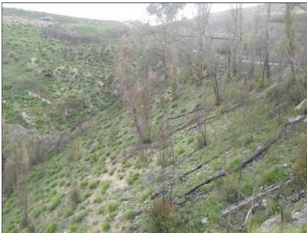
Foto J.1 – Panoramica della zona interessata dallo sviluppo della Frana L5_1.
