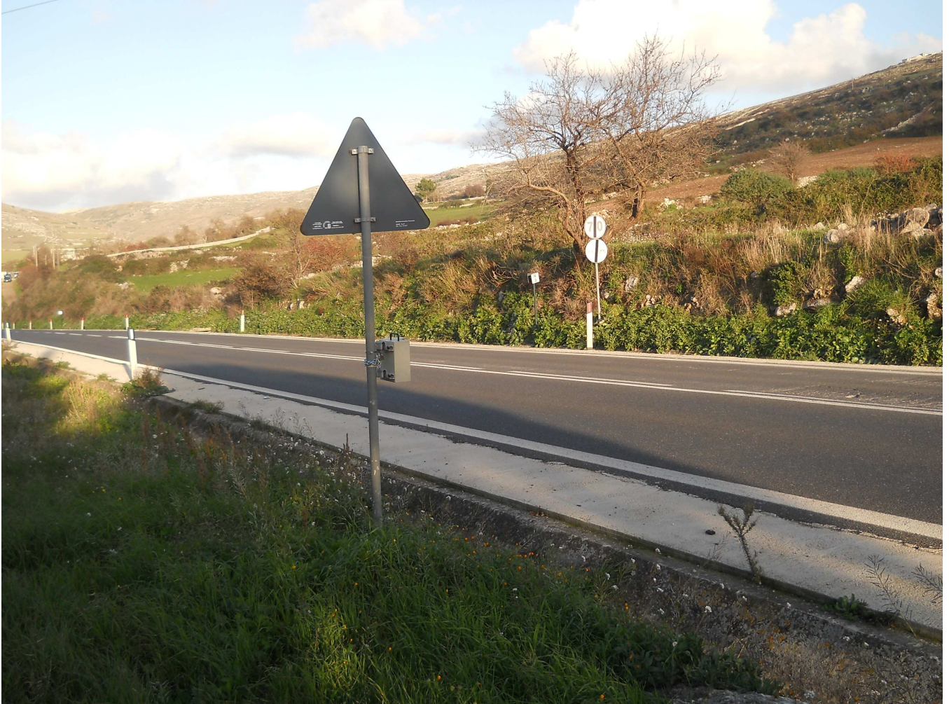
FOTO 3 Veduta fotografica della postazione di rilievo di traffico con contatraffico.
