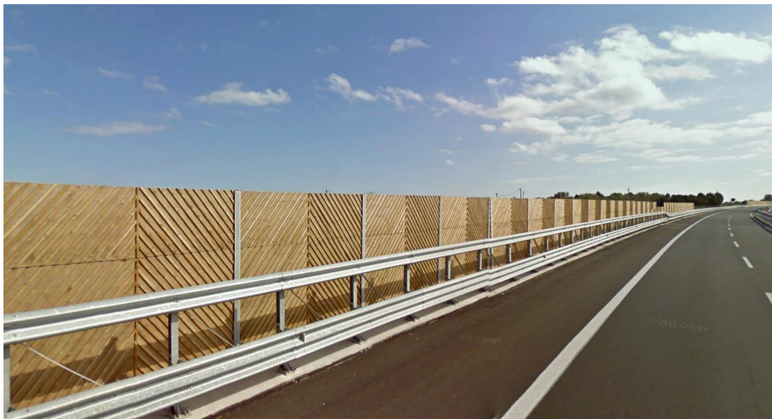
Figura E.1: Barriere antirumore lungo l'Autostrada Catania - Siracusa
