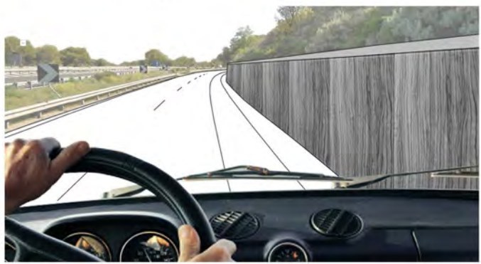
TIPOLOGIA DI RIVESTIMENTO DEI MURI DI SOSTEGNO CON PANNELLI PREFABBRICATI CON MATRICE A CORTECCIA DI LEGNO
