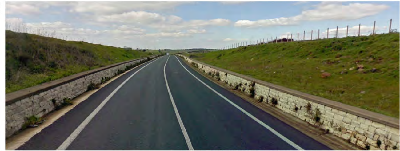
IA. VISTA DELLA STRADA STATALE 514 ESISTENTE
