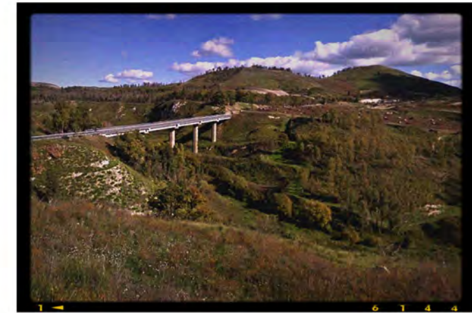
I. VISTA ATTUALE DELL'AREA CON IL PONTE "MANGALAVITE", PARTE DEL TRACCIATO DELLA SS 514 ESISTENTE. L'AREA "PIANO DELLE ROSE" E' STATA INDIVIDUATA COME AREA DI SPICCATO VALENZA PAESAGGISTICA E NATURALISTICA DATA LA PRESENZA DI AREE FORESTALI E CORSI D'ACQUA. L'AREA DI CANTIERE, DI 13740 MQ, SOTTOSTANTE IL VIADOTTO IN PROGETTO SARA' RINATURALIZZATA ATTRAVERSO LA MESSA A DIMORA DI N.2198 ESEMPLARI DI SPECIE ARBOREE E ARBUSTIVE, CREANDO LE CONDIZIONI PER UN CORRIDOIO ECOLOGICO PER IL PASSAGGIO FAUNISTICO E ITTICO.
