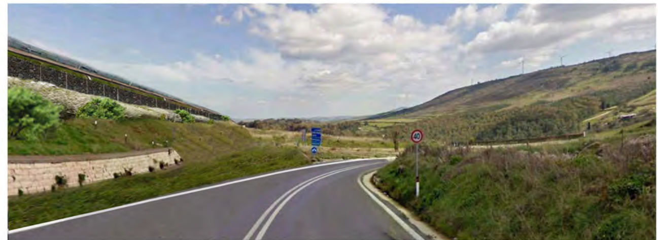
IB. VISTA DELL'AREA DOPO GLI INTERVENTI IN PROGETTO. L'INTERVENTO PREVEDE IL RIMODELLAMENTO CON RIPIANTO DI TERRENO E LA RINATURIZZAZIONE A PRATO DELL'AREA DI SEDIME STRADALE DISMESSO. SARANNO MESSI A DIMORA N.9 ALBERI DI QUERCIA TRAPIANTATI. IL MURO CONTRORIPA DEL RILEVATO AUTOSTRADALE IN PROGETTO SARA' RIVESTITO CON PANNELLI PREFABBRICATI CON FINITURA SUPERFICIALE IN PIETRA. PER TUTTA LA LUNGHEZZA DELLO STESSO MURO (360 METRI) E' PREVISTA LA SISTEMAZIONE DI UNA SIEPE ARBUSTIVA
