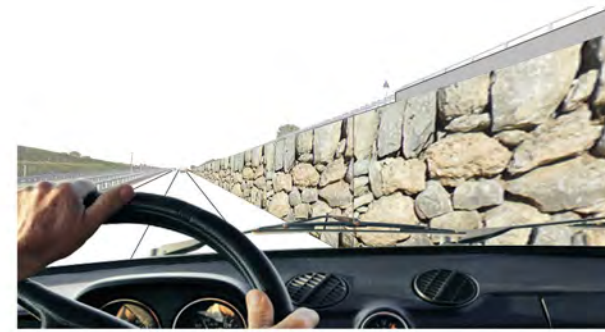
TIPOLOGIA DI RIVESTIMENTO DEI MURI DI SOSTEGNO CON MATRICE IN PIETRA A ORDITURA IRREGOLARE
