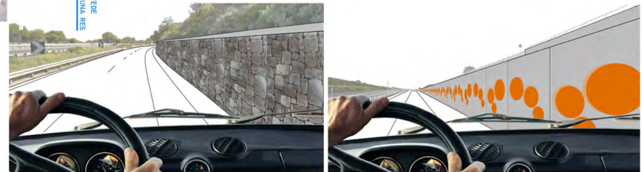
TIPOLOGIA DI RIVESTIMENTO DEI MURI DI SOSTEGNO CON PANNELLI PREFABBRICATI CON MATRICE IN PIETRA A ORDITURA REGOLARE E CON FINITURA SUPERFICIALE COLORATA CON MOTIVI STILIZZATI EVOCATIVI DELL'AGRUMETO
