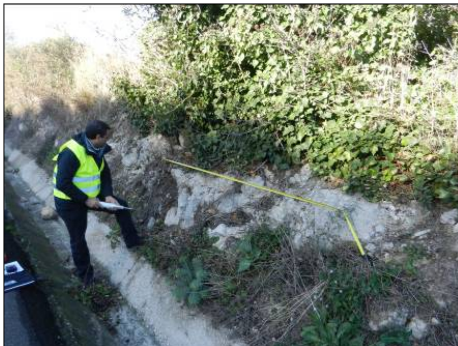
Figura A-4 Stazione geomeccanica SG4
