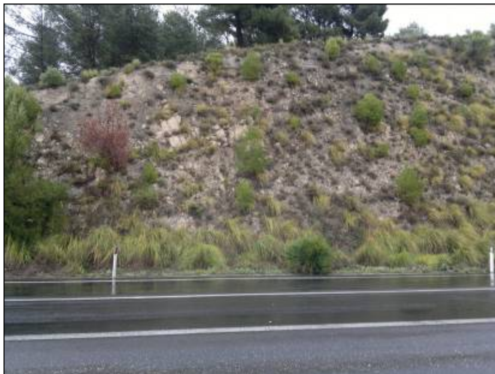
Figura A-12 Stazione geomeccanica SG40
