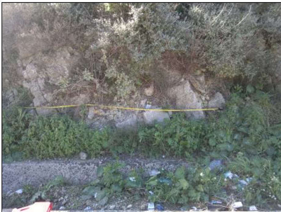
Figura A-7 Stazione geomeccanica SG7
