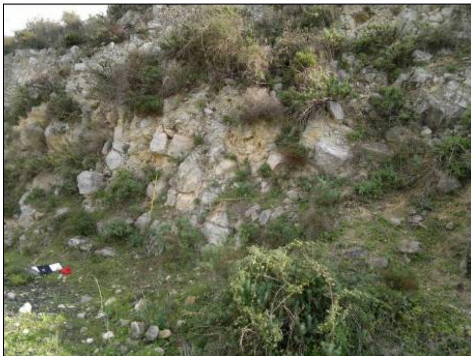
Figura A-3 Stazione geomeccanica SG3
