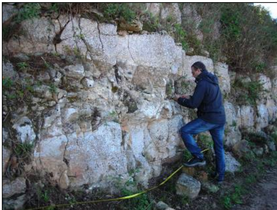
Figura A-1 Stazione geomeccanica SG1
