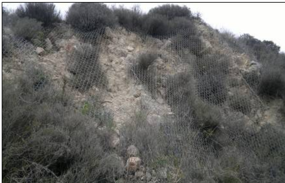
Figura A-15 Stazione geomeccanica SG48
