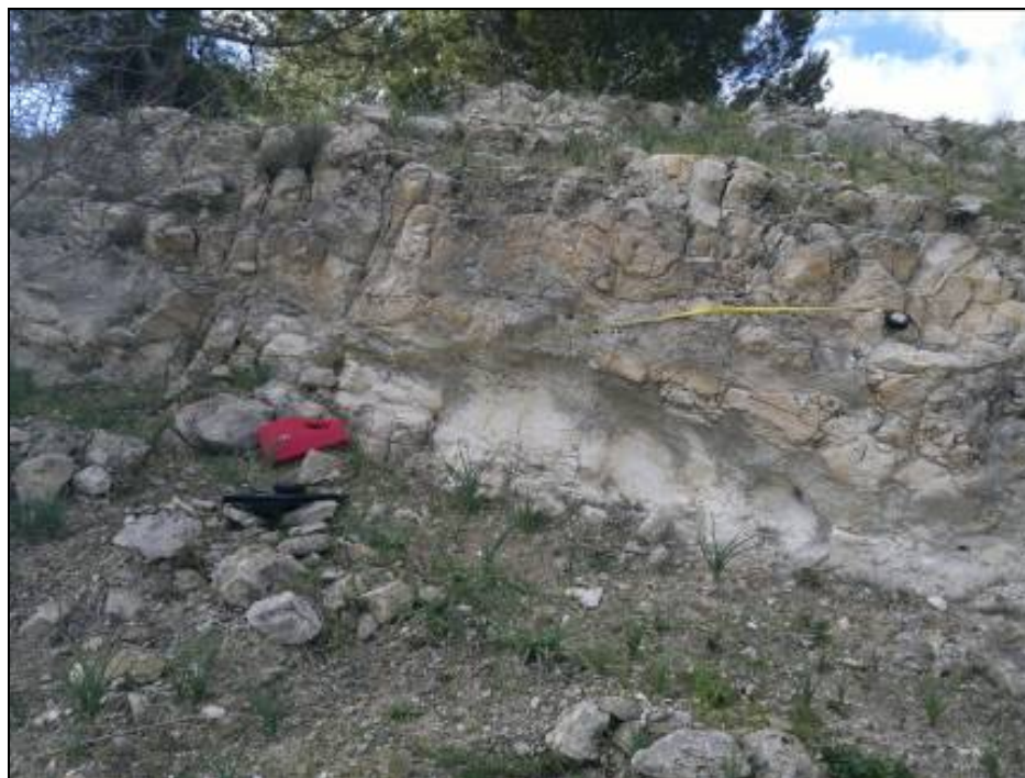
Figura A-8 Stazione geomeccanica SG8
