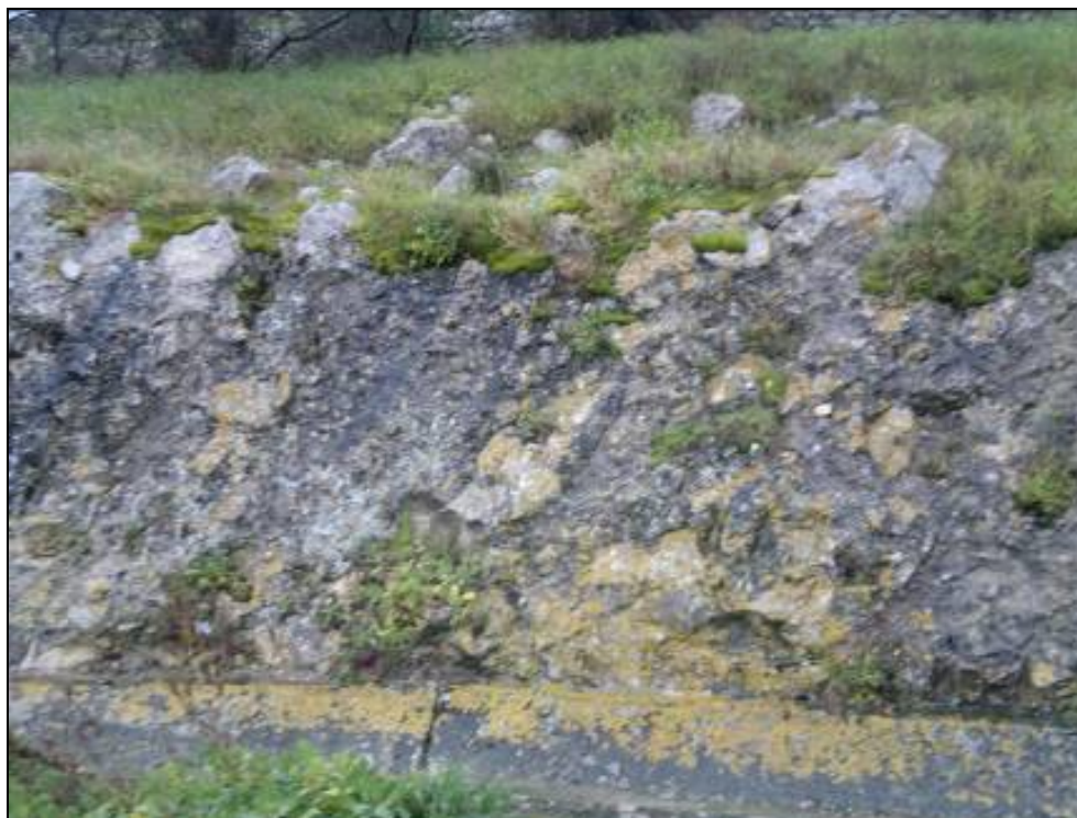
Figura A-10 Stazione geomeccanica SG38
