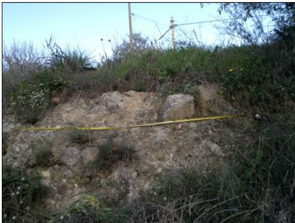
Figura A-9 Stazione geomeccanica SG9
