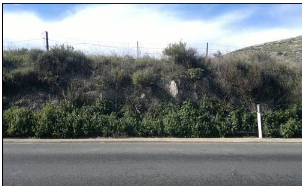
Figura A-14 Stazione geomeccanica SG42
