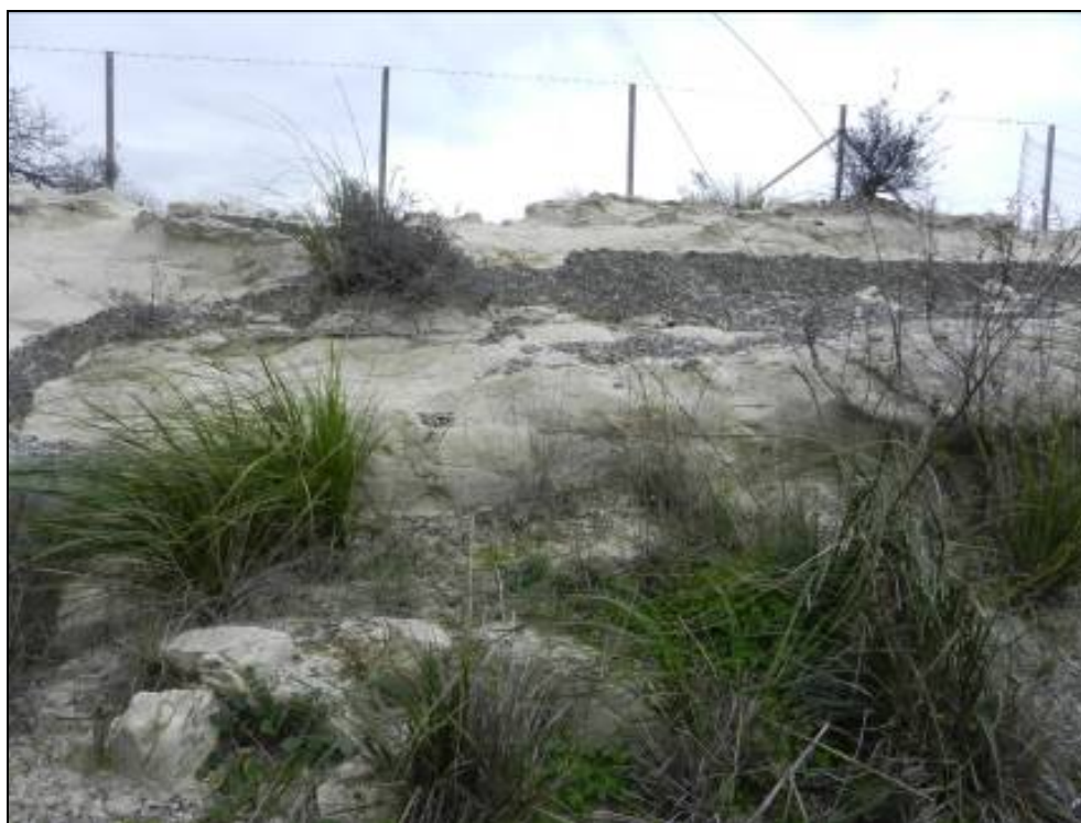
Figura A-3 Stazione geomeccanica SG45
