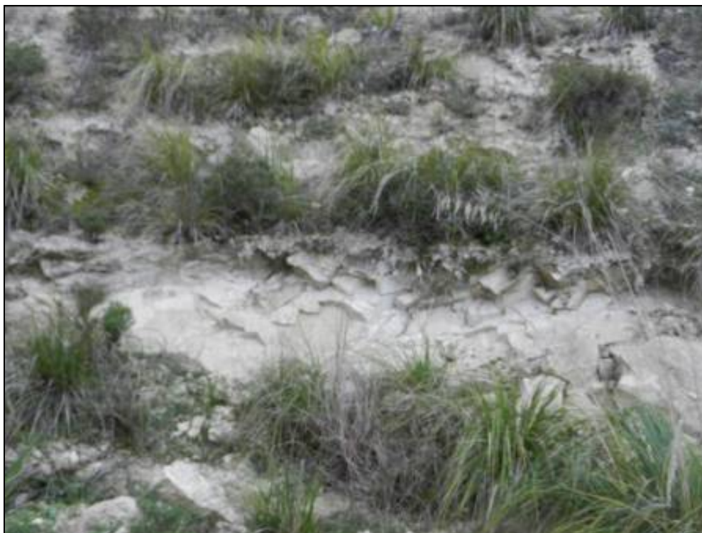
Figura A-4 Stazione geomeccanica SG47
