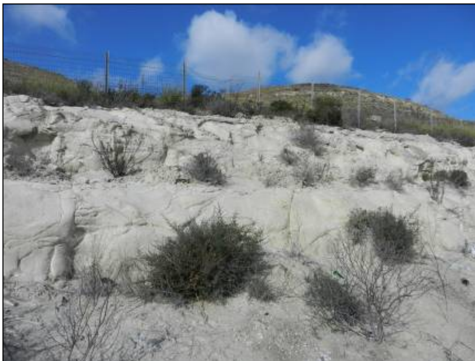
Figura A-1 Stazione geomeccanica SG21
