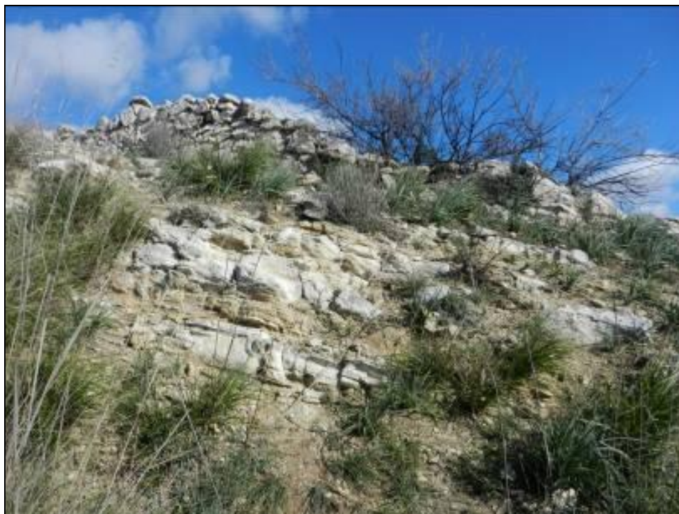
Figura A-3 Stazione geomeccanica SG24
