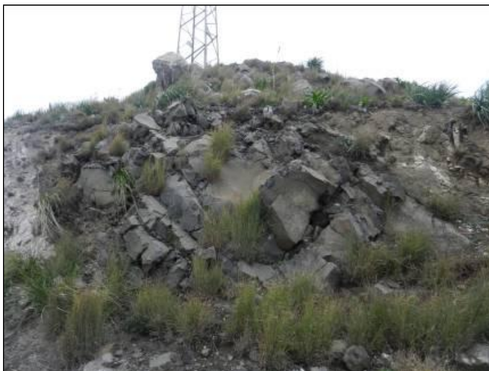
Figura A-5 Stazione geomeccanica SG26
