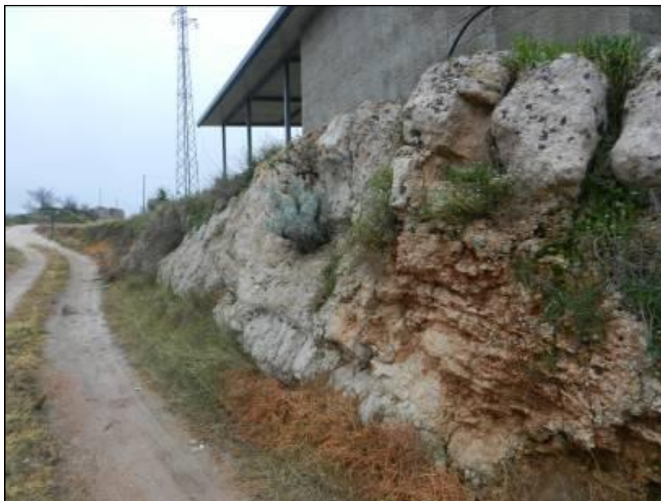
Figura A-8 Stazione geomeccanica SG29
