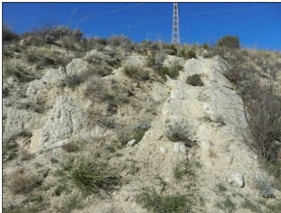
Figura A-1 Stazione geomeccanica SG22
