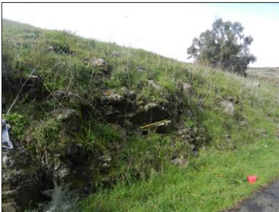
Figura A-4 Stazione geomeccanica SG16
