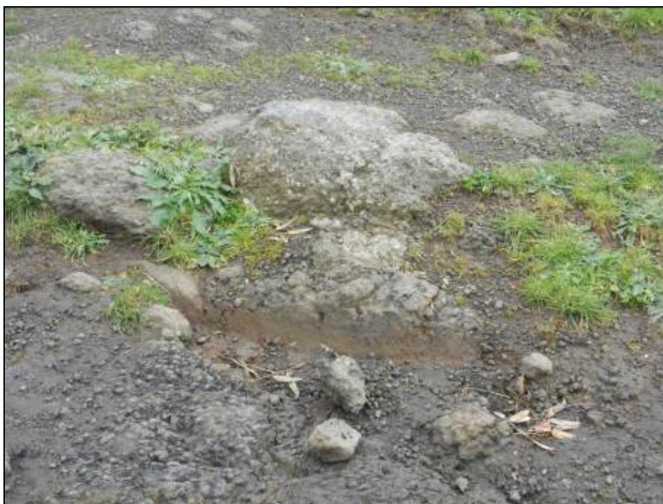
Figura A-6 Stazione geomeccanica SG18
