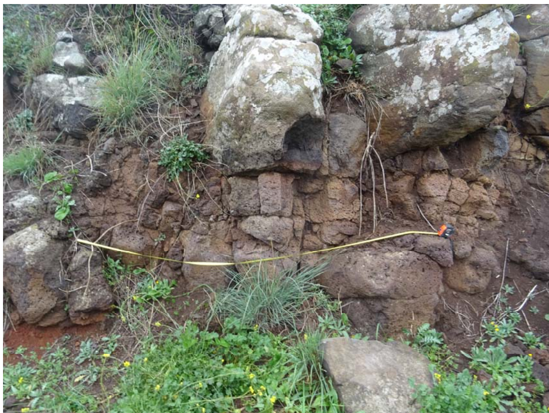
Figura A-12 Stazione geomeccanica SG59
