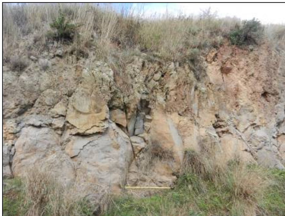
Figura A-5 Stazione geomeccanica SG17
