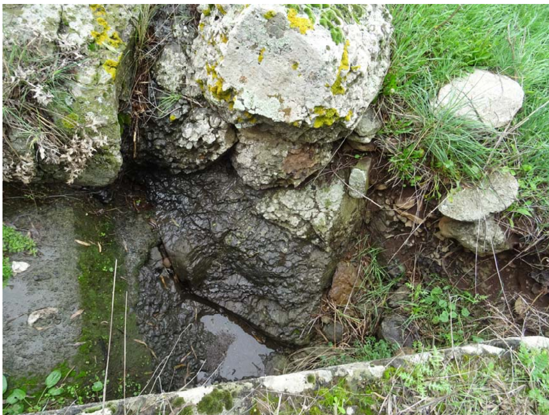
Figura A-14 Stazione geomeccanica SG61
