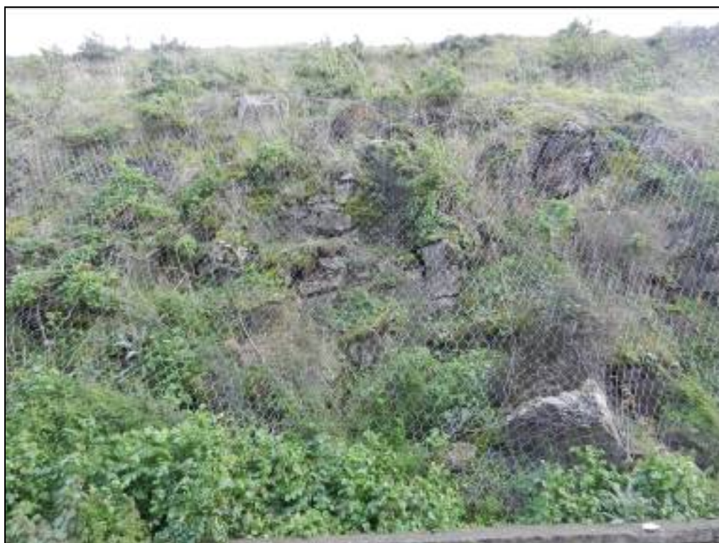
Figura A-9 Stazione geomeccanica SG46
