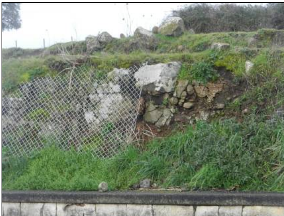
Figura A-8 Stazione geomeccanica SG20
