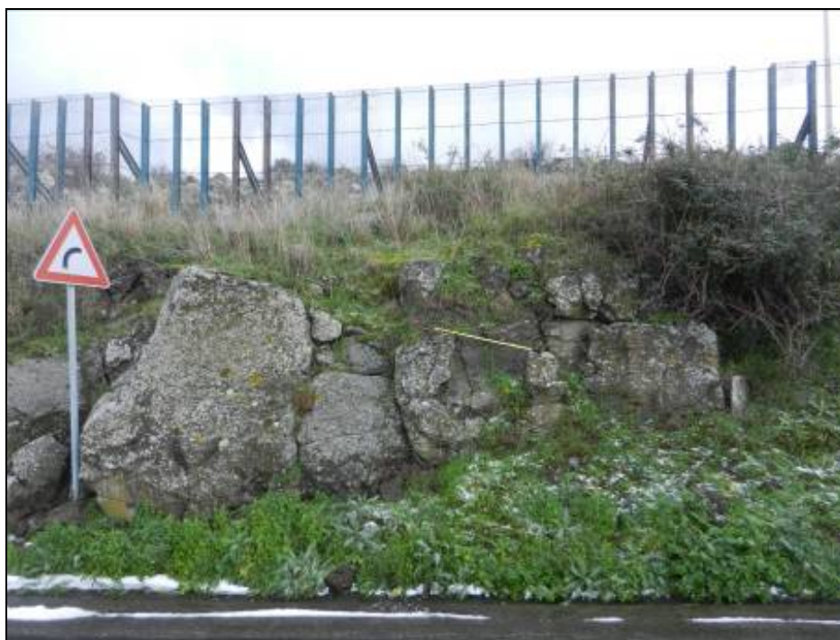
Figura A-3 Stazione geomeccanica SG15
