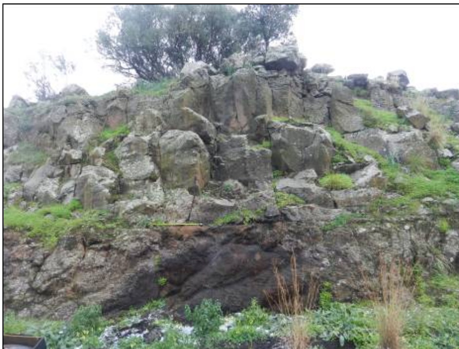
Figura A-2 Stazione geomeccanica SG14
