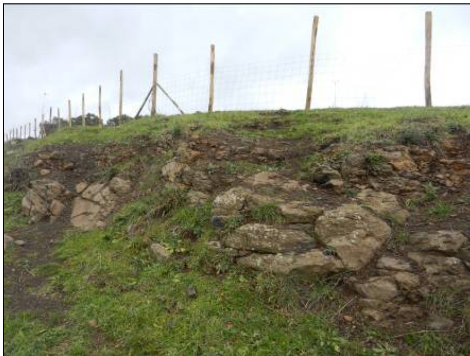
Figura A-7 Stazione geomeccanica SG19
