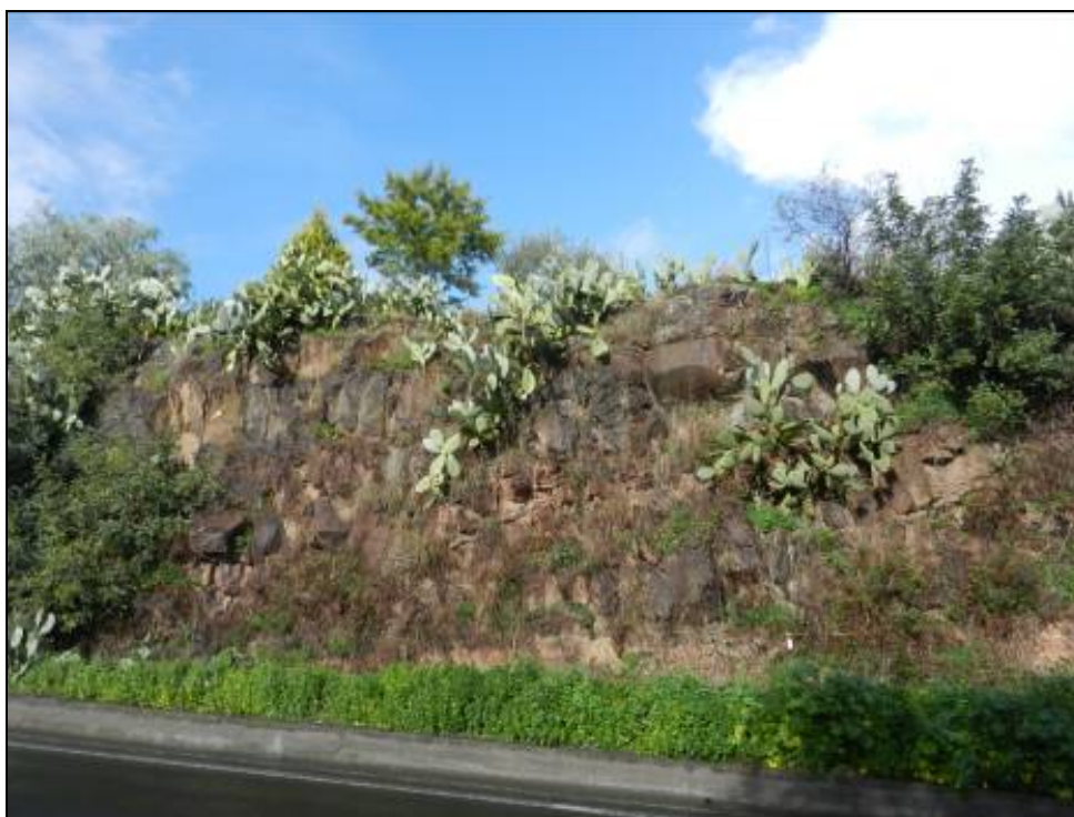
Figura A-1 Stazione geomeccanica SG13
