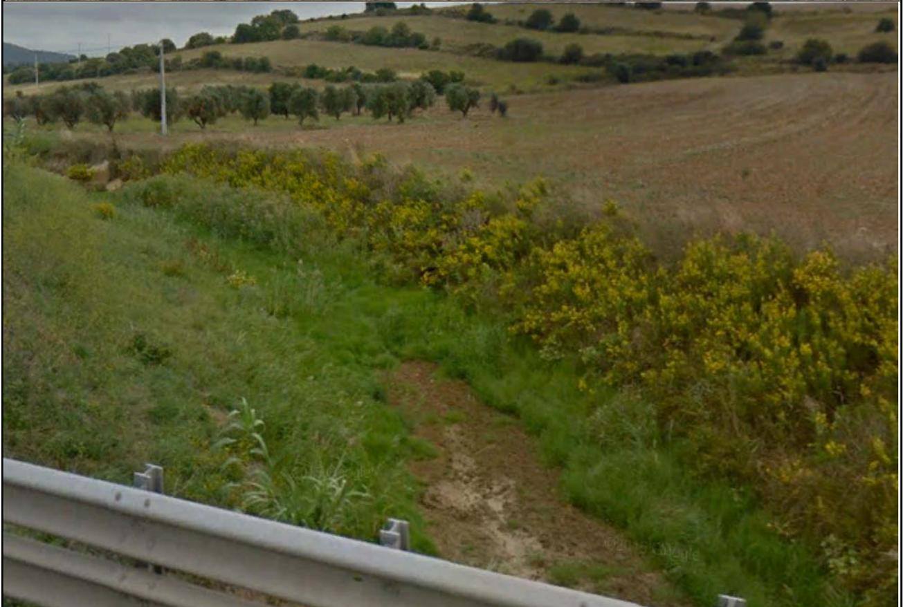
Si tratta di un canale artificiale, realizzato per la bonifica di Talamone, presenta quindi percorso e sezione non naturali, la vegetazione è molto ridotta e controllata con sfalci periodici. Tra le progressive 0+100 e 0+900 viene realizzata una modifica del tracciato.
