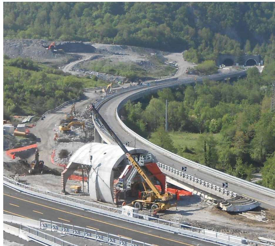
Foto n. 4: corso d'opera della foto n. 3
