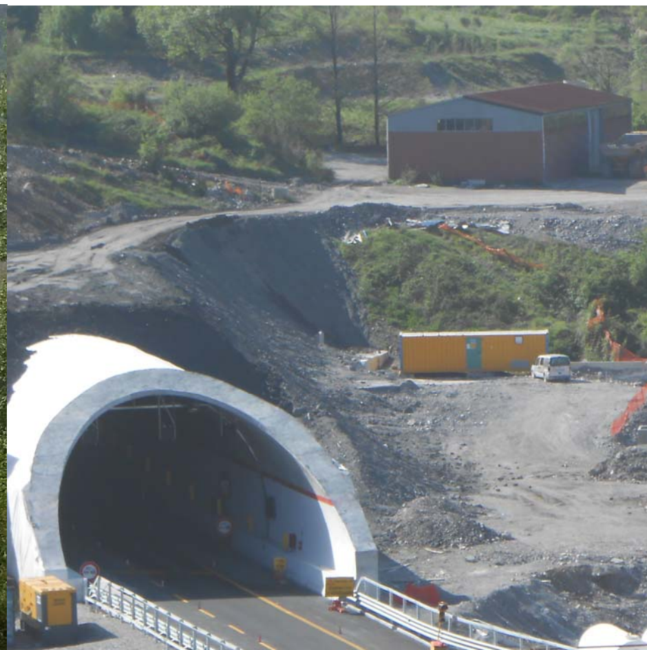
Foto n. 2: corso d'opera della foto n. 1
