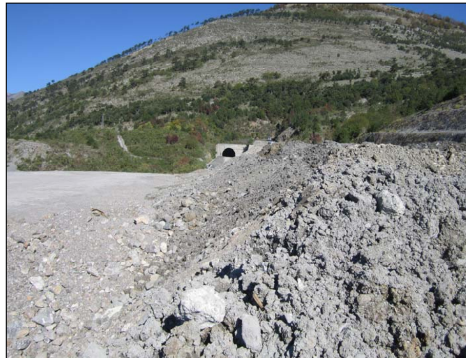
Foto n. 2: corso d'opera della foto n. 1
