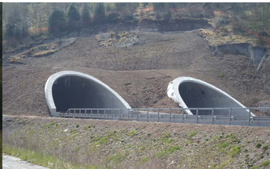
Foto n. 2: corso d'opera della foto n. 1
