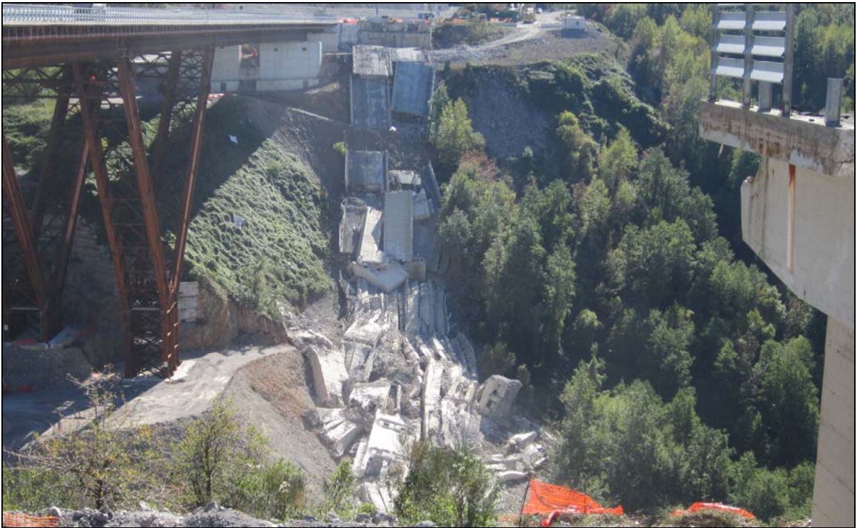
Foto n. 4: corso d'opera della foto n. 3
