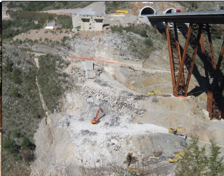
Foto n. 2: corso d'opera della foto n. 1
