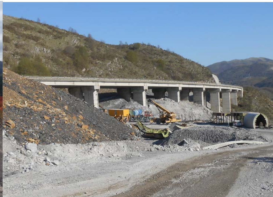
Foto n. 4: corso d'opera della foto n. 3
