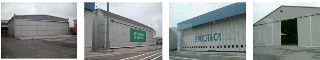
Fig. 45 - Hangar Aviazione Generale
