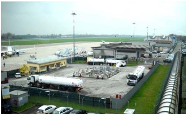
Fig. 55 - L'area deposito carburante
