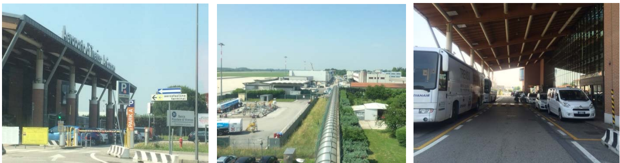
Fig. 28 - Accessibilità e viabilità e percorso pedonale protetto esistente
