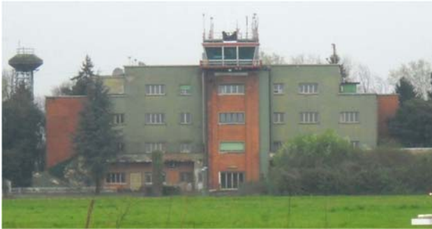
Fig. 49 - La torre di controllo
