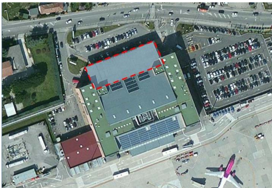
Fig. 94 - Vista zenitale dell'ampliamento
