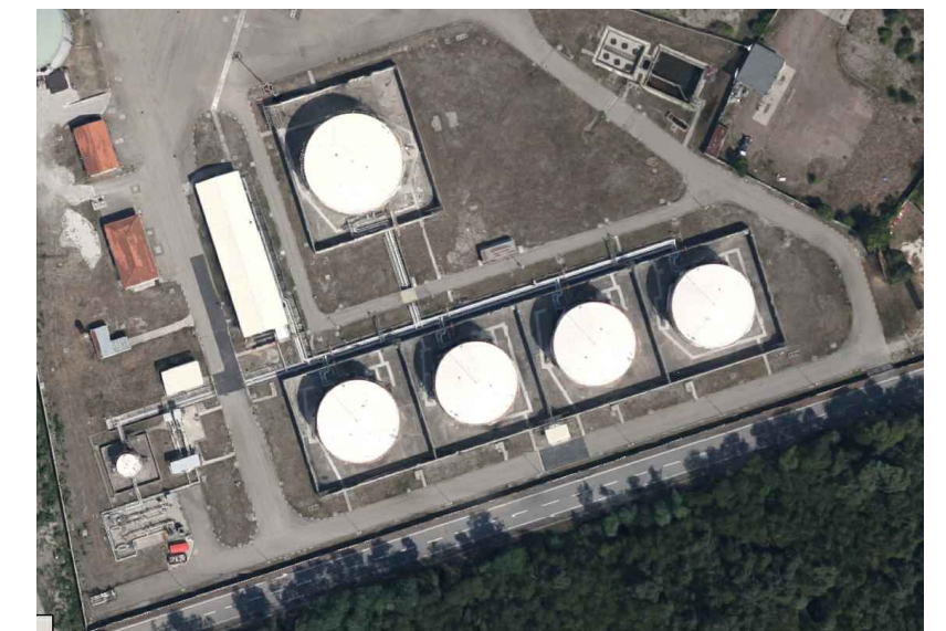
Esempio Malpensa_Deposito Carburanti
