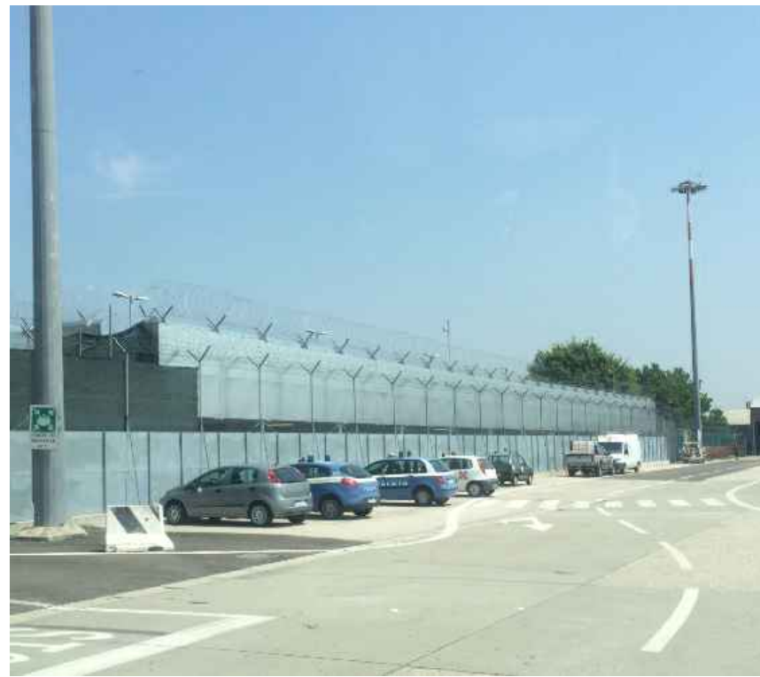
Strada perimetrale esistente
