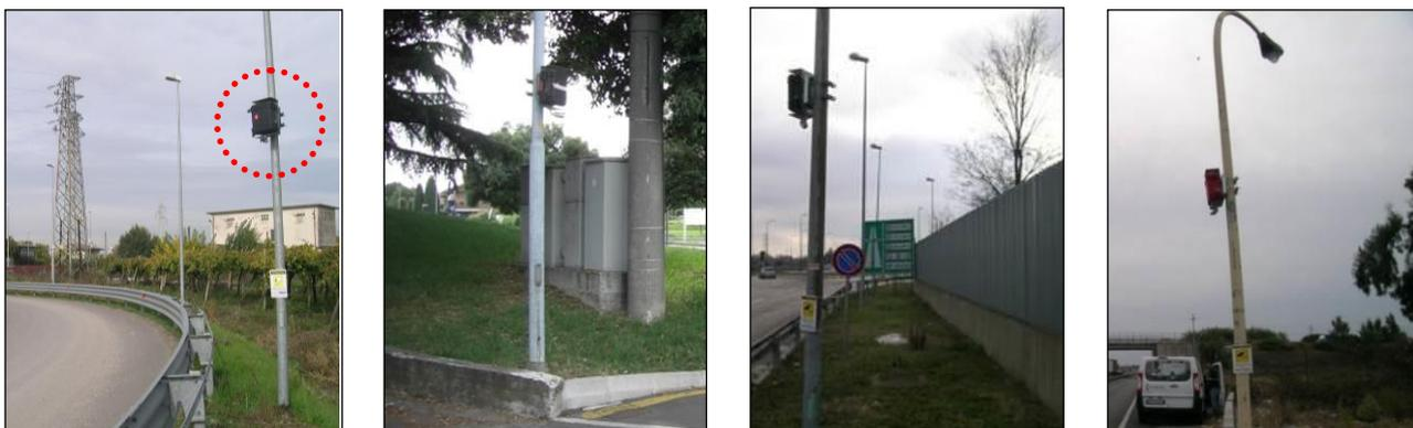
**Figura 3-6: Esempi di posizionamento delle telecamere ad infrarossi**
