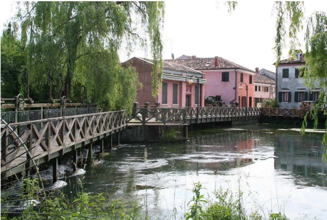
Figura C5-14 Vista delle paratoie di regolazione e del “l'Ex Mulino Granello”, sui quali affaccia “Villa Rosta”.
