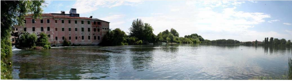
Figura C5-13 Vista panoramica del “Mulino Bordignon” sul Lago inferiore di Quinto.
