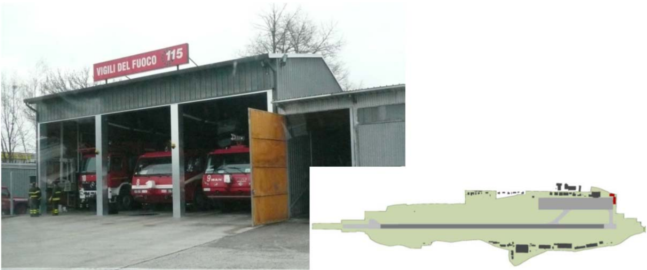
Figura B1-22 Presidio dei VVF, foto e localizzazione – stato di fatto.
