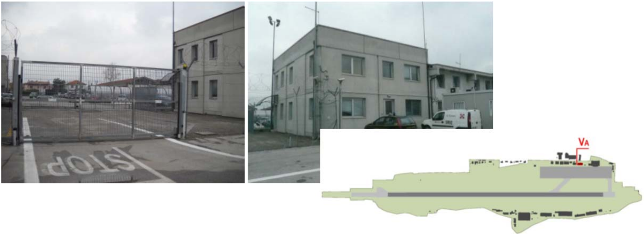
Figura B1-25 Varco di sicurezza e dogana, foto e localizzazione – stato di fatto.
