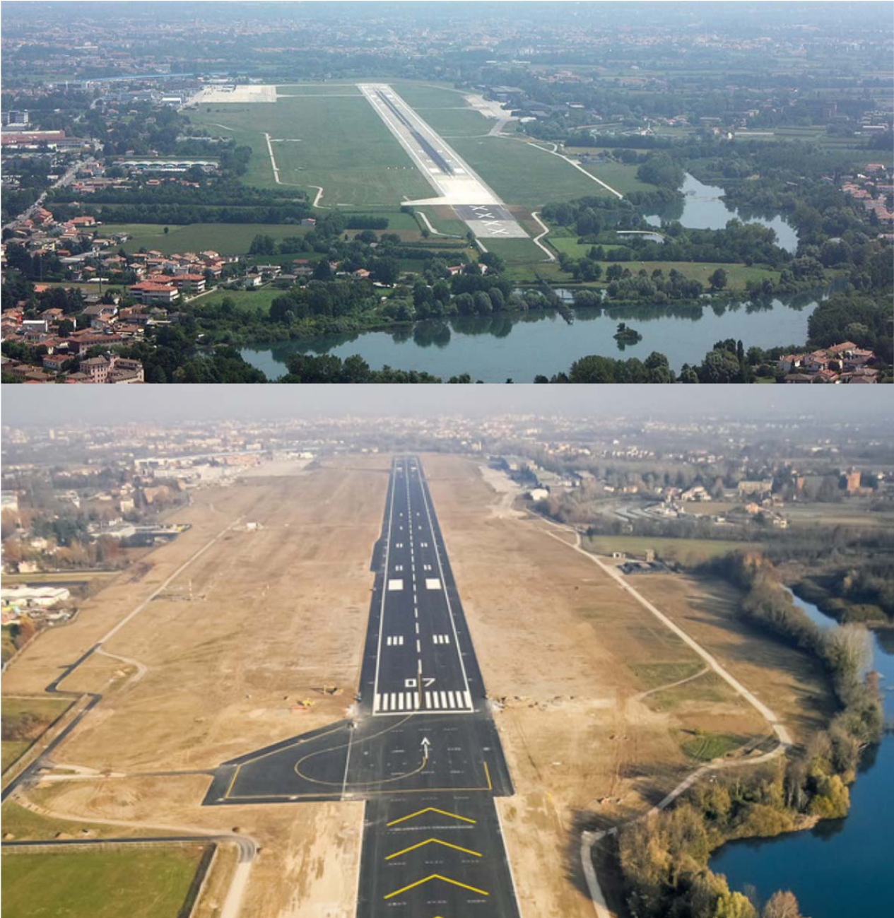
Figura B1-1 Vista aerea dell'aeroporto e della pista e del territorio circostante.
