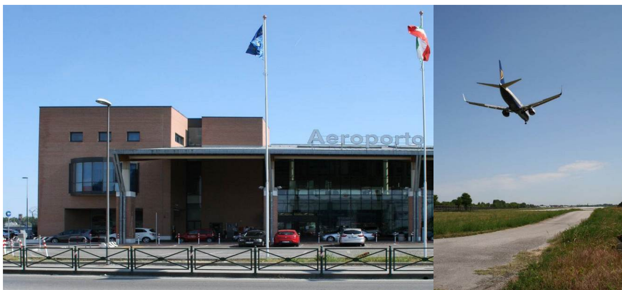
Figura D4-11 Il terminal e un aereo in atterraggio.
