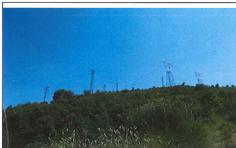
Img7 Elevato numero di elettrodotti in prossimità della Loc Riccetta (a breve distanza dal tracciato del nuovo elettrodotto Laino-Altomonte2) punto di osservazione Fiume Coscile salendo verso la Riccetta)
