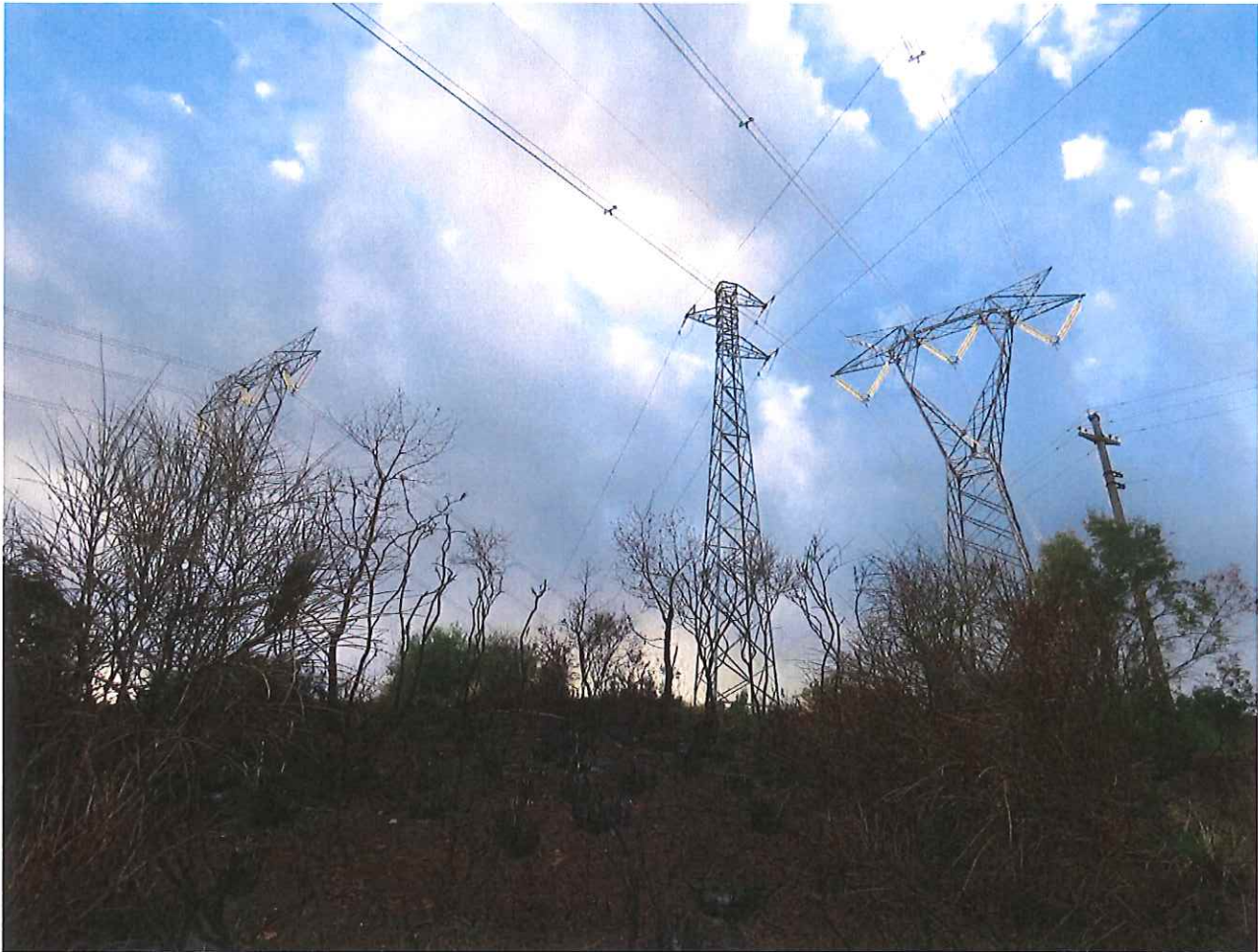
Img6. "Intreccio" di cavi in Loc. Cuppone poco distante dal previsto nuovo elettrodotto Laino-Altomonte2 -foto del 17-04-17
