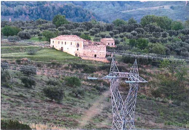
Img2. - Antica abitazione rurale posta alle spalle dell'elettrodotto 380kV Laino-Rossano (da dismettere)
