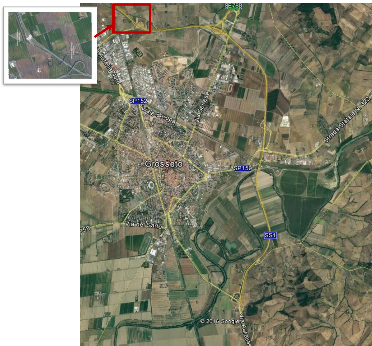
LA NUOVA COLLOCAZIONE DELLA BARRIERA DI ESAZIONE DI GROSSETO
