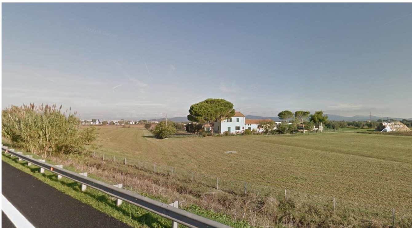
EDIFICIO POSTO IN CORRISPONDENZA DELLA BARRIERA DI GROSSETO “NORD”
