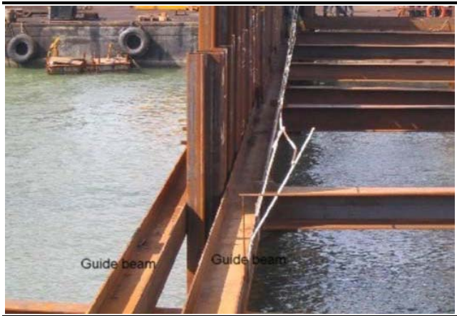
Figura 2.8 Tipologico di Dima di Posizionamento
