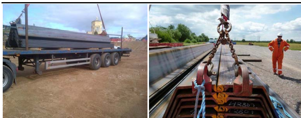
Figura 2.7 Movimentazione palancole
