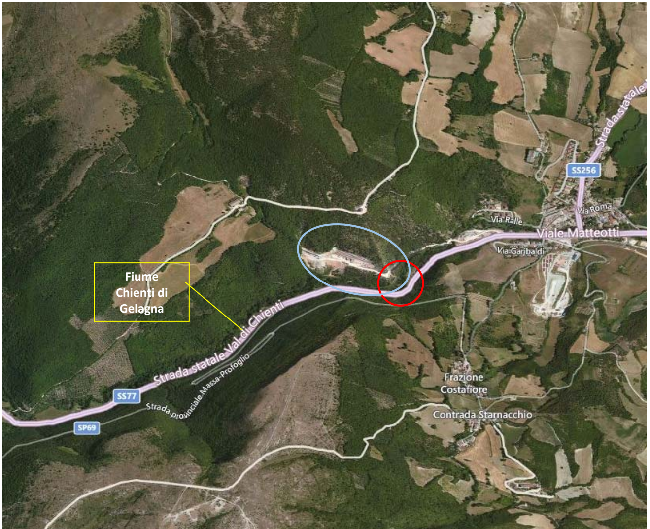
Figura 1: Localizzazione dell'area di cantiere S10 su ortofoto, con indicazione del guado oggetto di rimozione (indicato con un cerchio di colore rosso)
