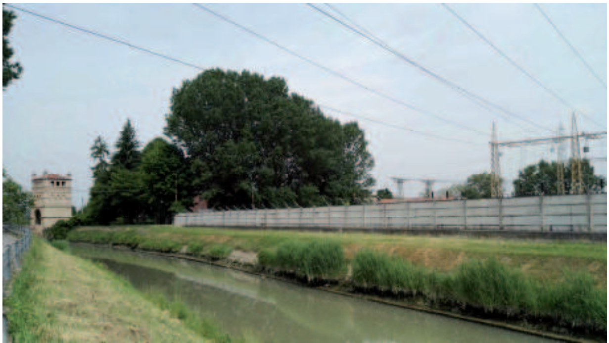
FOTO 2 - La torre detta Colombara e l'attuale Stazione elettrica esistente
