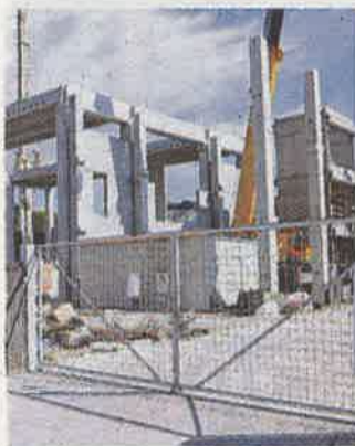
L'esterno della Climaveneta
