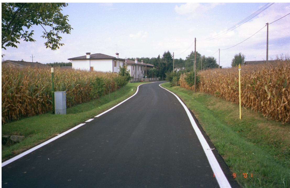
Foto 7/B: Attraversamento strada comunale
