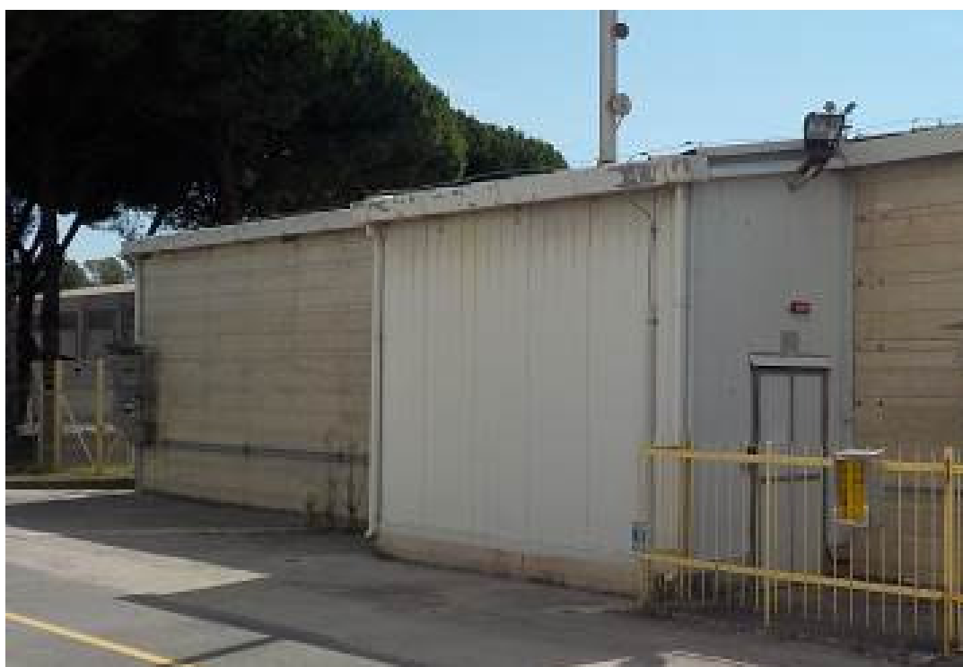
Figura 5-22 - Pannellatura locale tecnico (locale impianto ventilazione delle nuove fosse)
