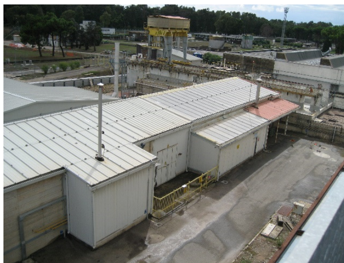
Figura 5-7 - Locale ventilazione e area di ingresso e spogliatoi
