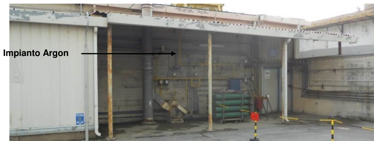
Figura 5-8 - Copertura impianto Argon
