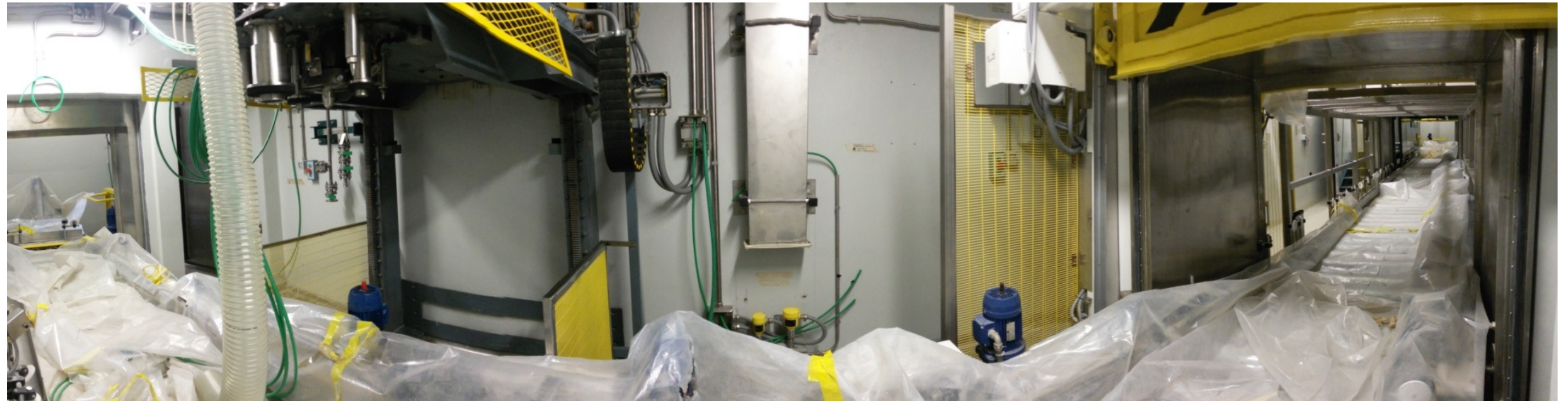
Figura 4-8 - Edificio di Condizionamento
