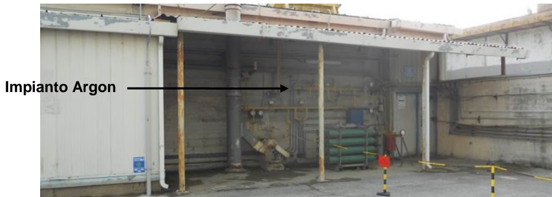
Figura 3-33 – Copertura impianto Argon
