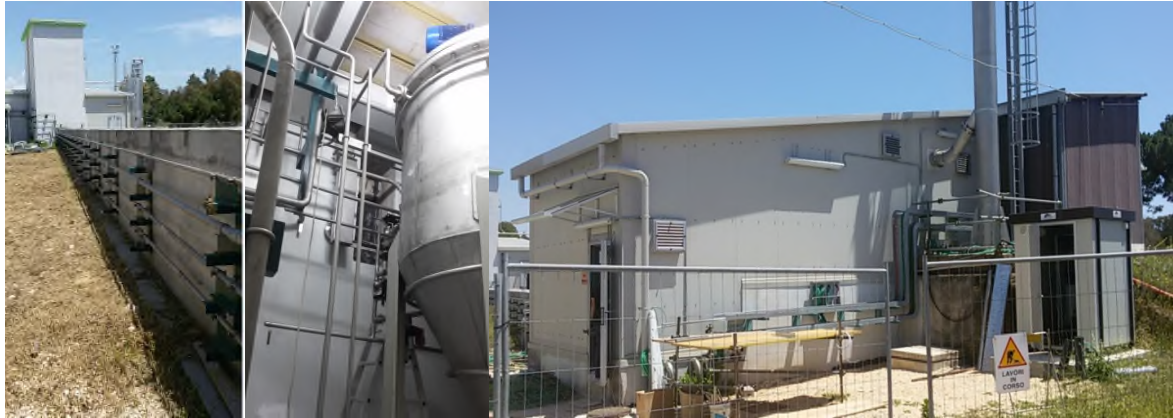
Figura 3–14 – Edificio di estrazione e cunicolo di collegamento
