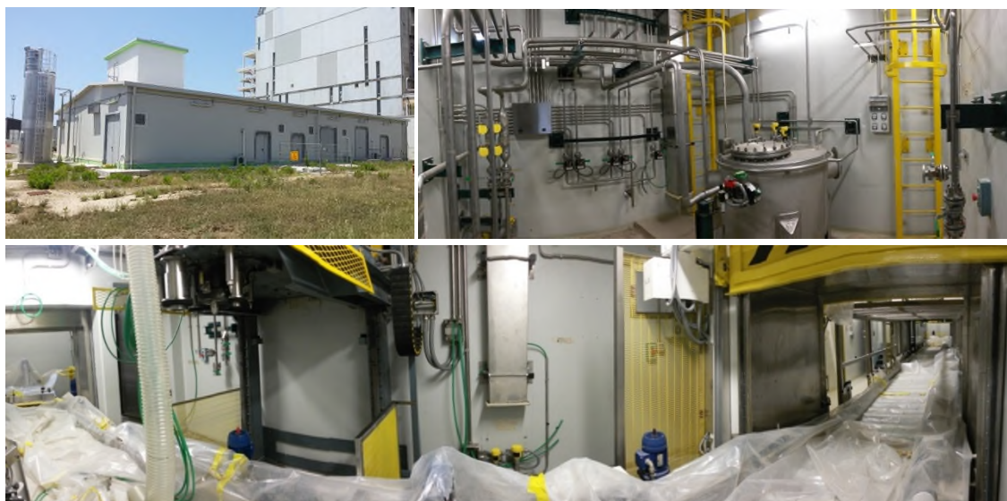
Figura 3-17 – Edificio di Condizionamento
