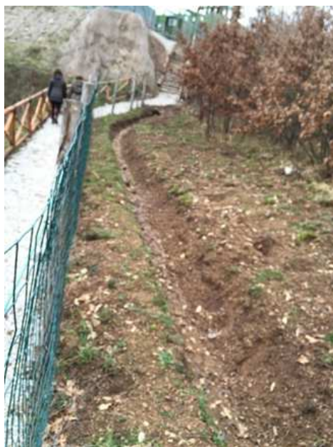
Figura 3-1: Interventi di regimazione delle acque superficiali
