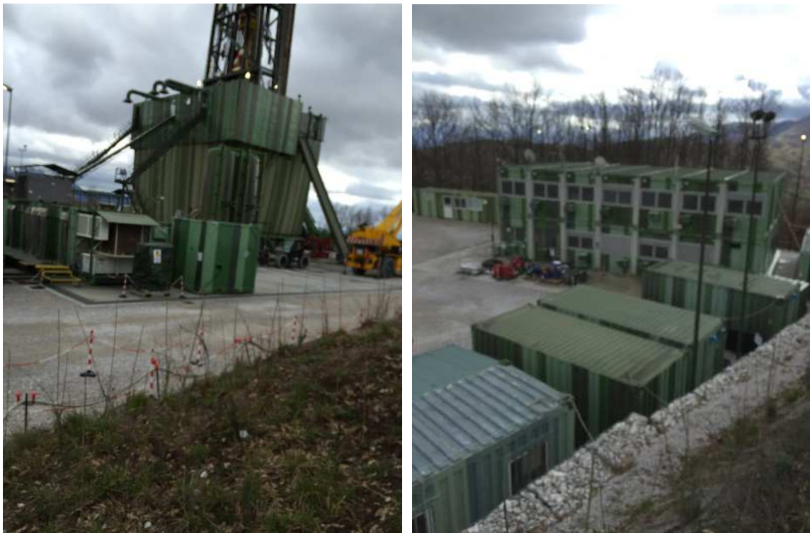
Figura 3-2: Interventi di mascheramento dell’impianto di perforazione e dei cabinati
