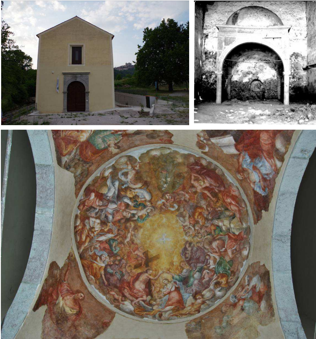
Figura 8.6: Marsico Nuovo - Chiesa di Santa Maria di Costantinopoli. Vedute della facciata principale della chiesa e del fiume Agri che gli scorre praticamente di fianco, della zona dell'altare e della volta affrescata.
