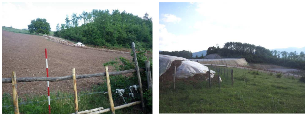
Figura 4.4: Area Pozzo Pergola 1 – Strada di accesso (foto a sinistra) e Postazione Pozzo Pergola 1, vista E (foto a destra).
