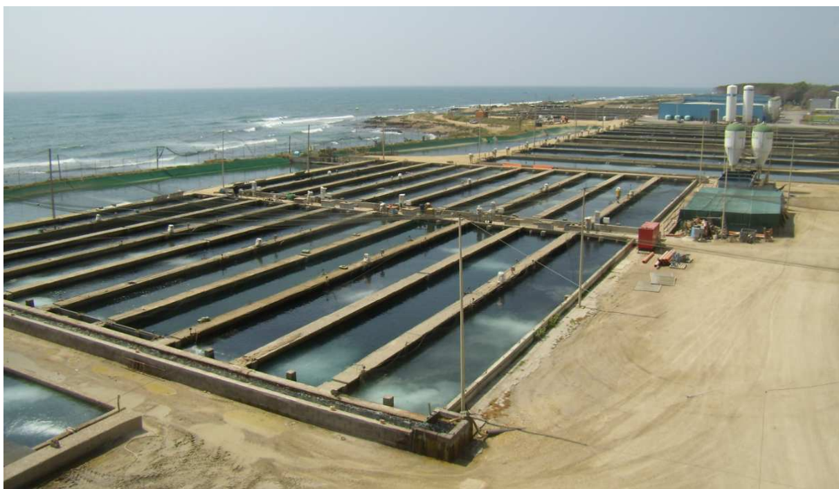
Vista dell'attuale impianto di piscicoltura.
