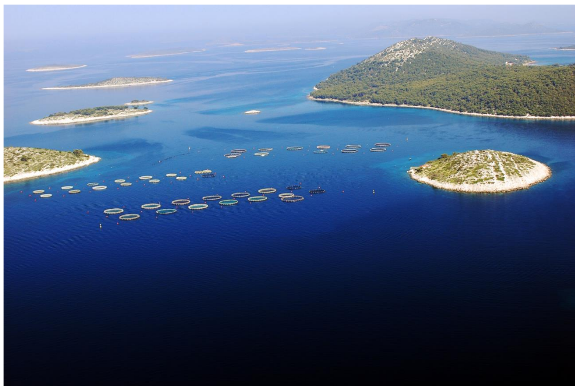
Figura 5.6.2 – Esempio di impianto offshore di proprietà di Civita Ittica
