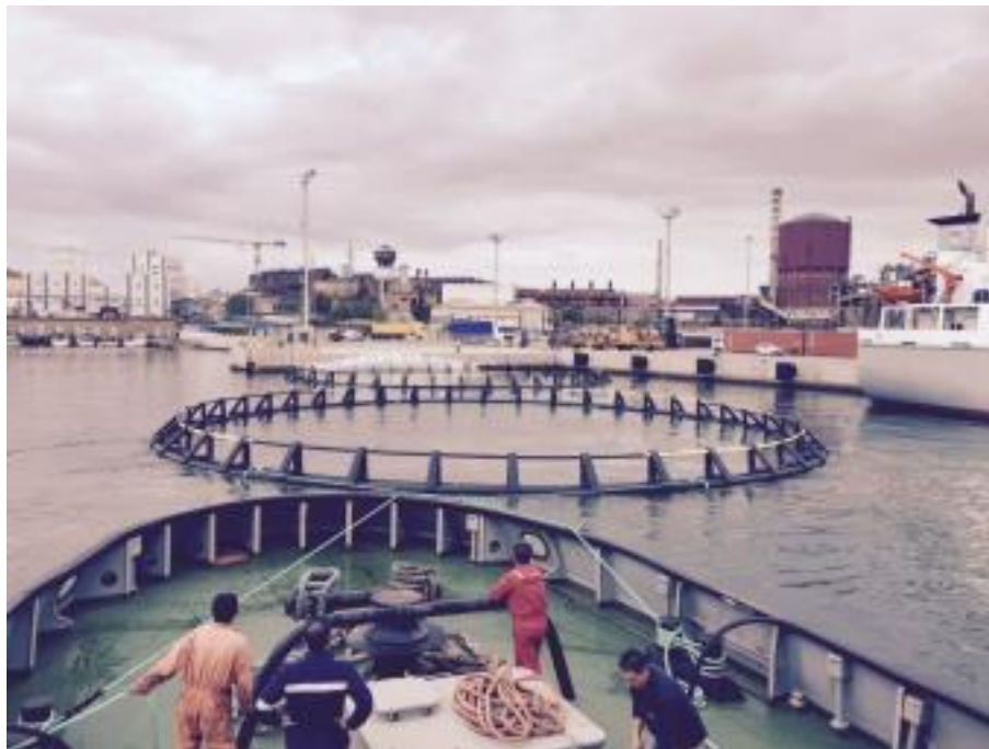
Figura 3.4.2 – Traino per il successivo posizionamento delle gabbie in un impianto di proprietà di Civita Ittica
