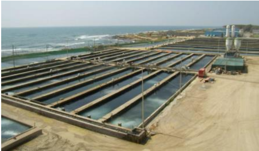
Figura 4.7.2 – Impianto ittico a terra esistente
