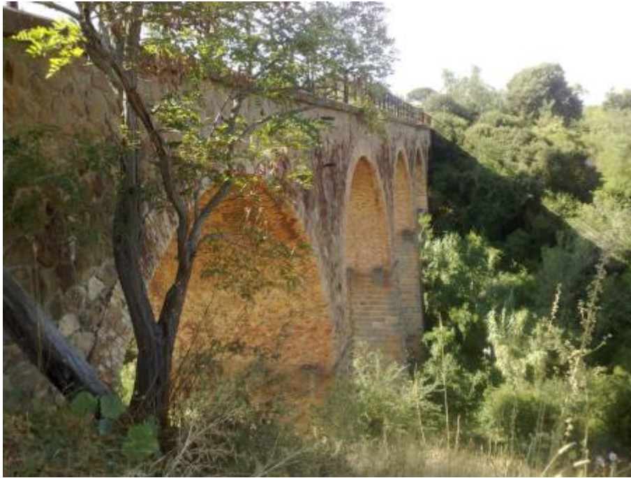
Figura 4.7.4 – Antica ferrovia Orte-Civitavecchia
