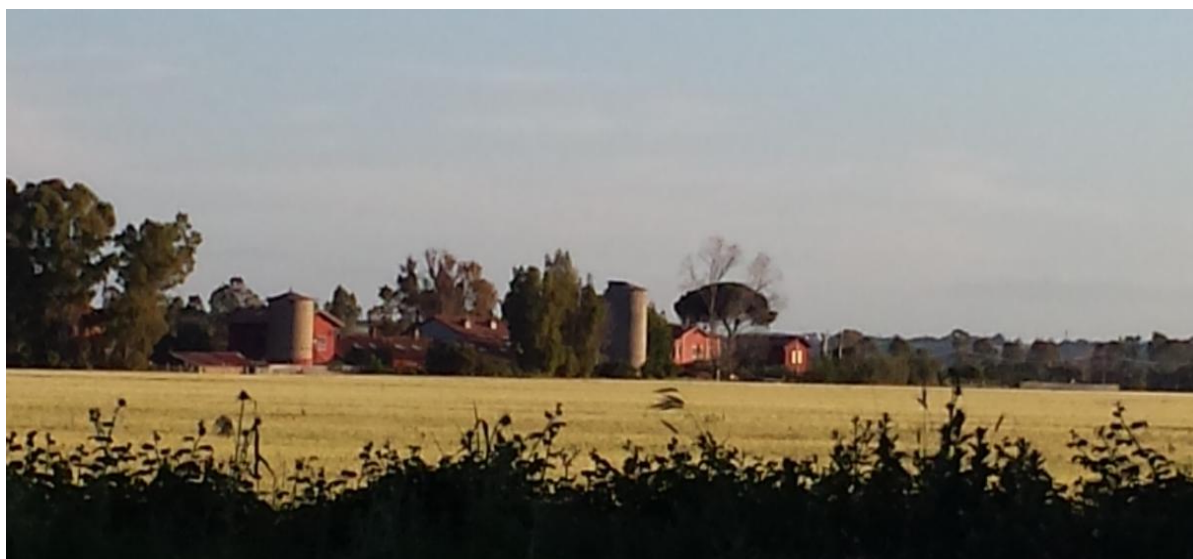
Centro agricolo 8 di Viale Campo Salino – Uno dei centri che si prevede di abbattere
