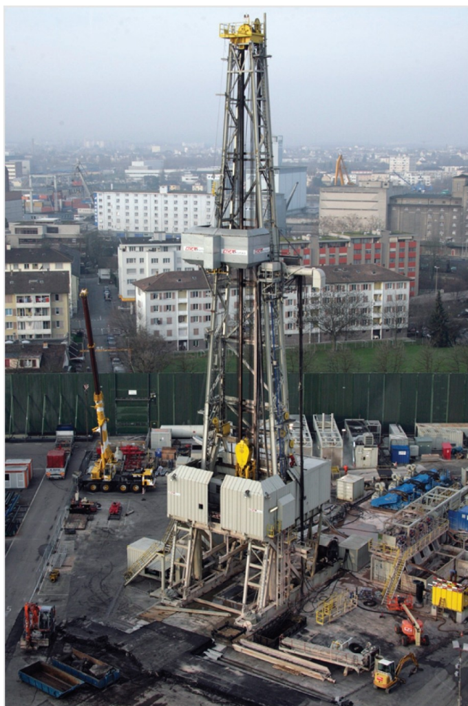
Fig. 32. Perforazione a Basilea. L'iniezione fu eseguita con 340 bar a testa-pozzo.
