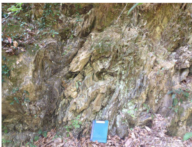
Figura 5 – Argilloscisti pieghettati dalla fase D3 in sponda destra del Rio Trasta, bassa Val Polcevera (GE).
