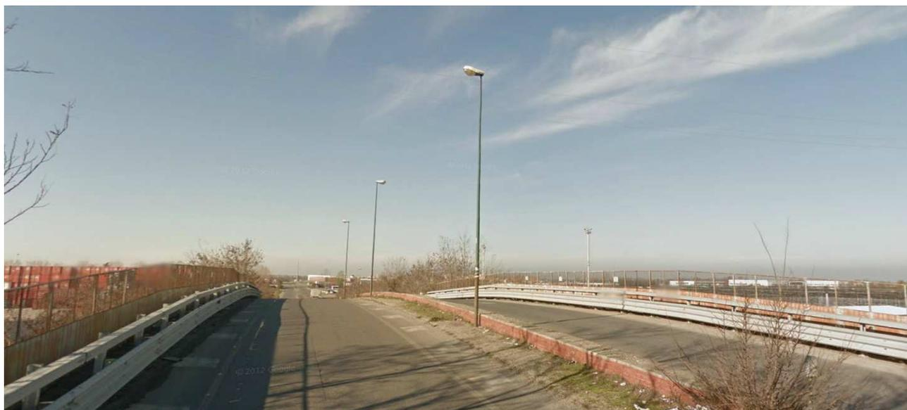
Sull'opera di scavalco esistente avviene un restringimento delle carreggiate che presentano una larghezza di circa 6,50 m con cordolo sullo spartitraffico.
