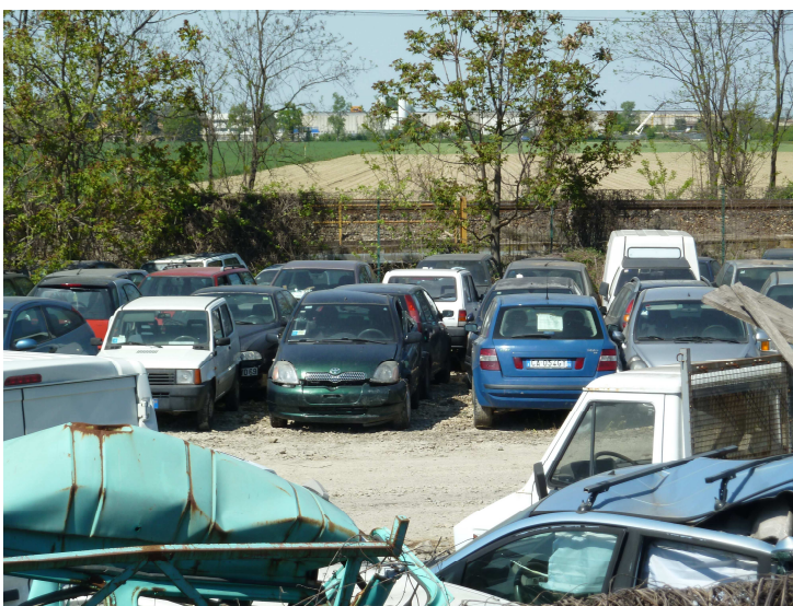
Area in cui dovrebbe trovarsi il canale di collegamento, in corrispondenza dei parapetti gialli è posizionato il tombino di cui alla foto precedente
