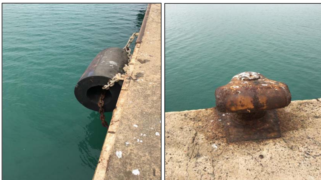
Figura 24: Fender e bitte presenti nella banchina del Porto Canale
