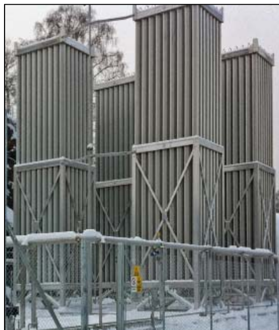
Figura 18: Vaporizzatori AAV
