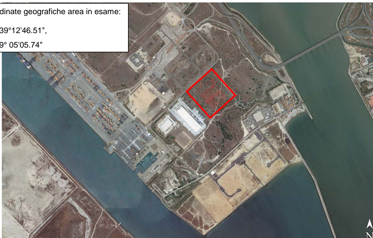
Figura 2 – Foto aerea (Google Earth, ripresa da 3 Km di altezza).
