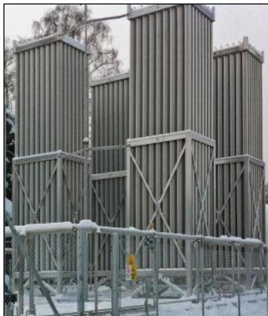
Figura 18: Vaporizzatori AAV
