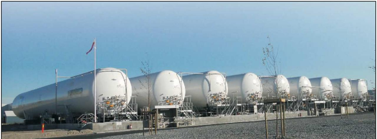
Figura 9 - Esempio di serbatoi criogenici (impianto GNL a Fredrikstad – Norvegia)
