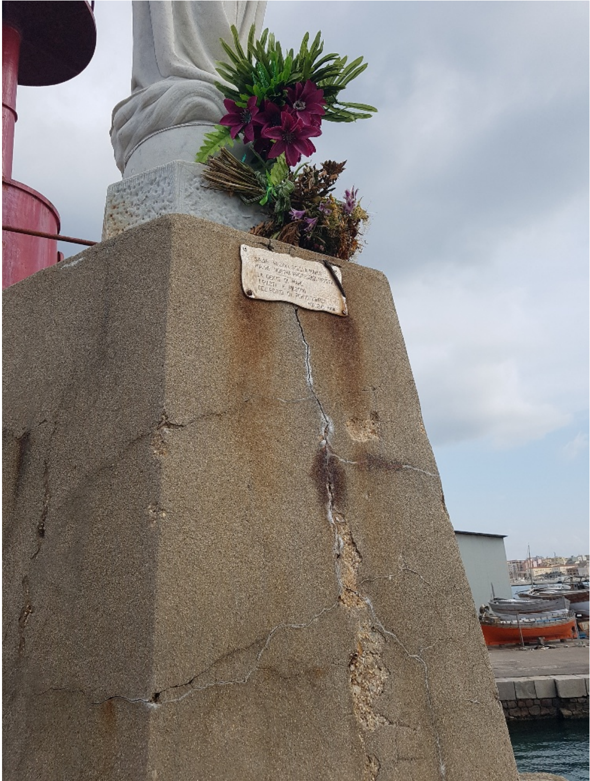
[Porto Torres - Porto Civico - Basamento in calcestruzzo]
