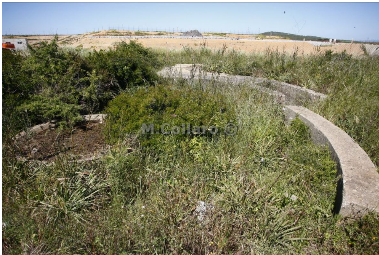
[Postazione di mitragliatrice - sullo sfondo la discarica di Porto Torres]
