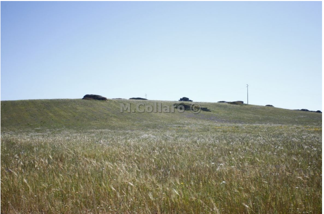
[Sbarramento Stintino - vista lato strada]
