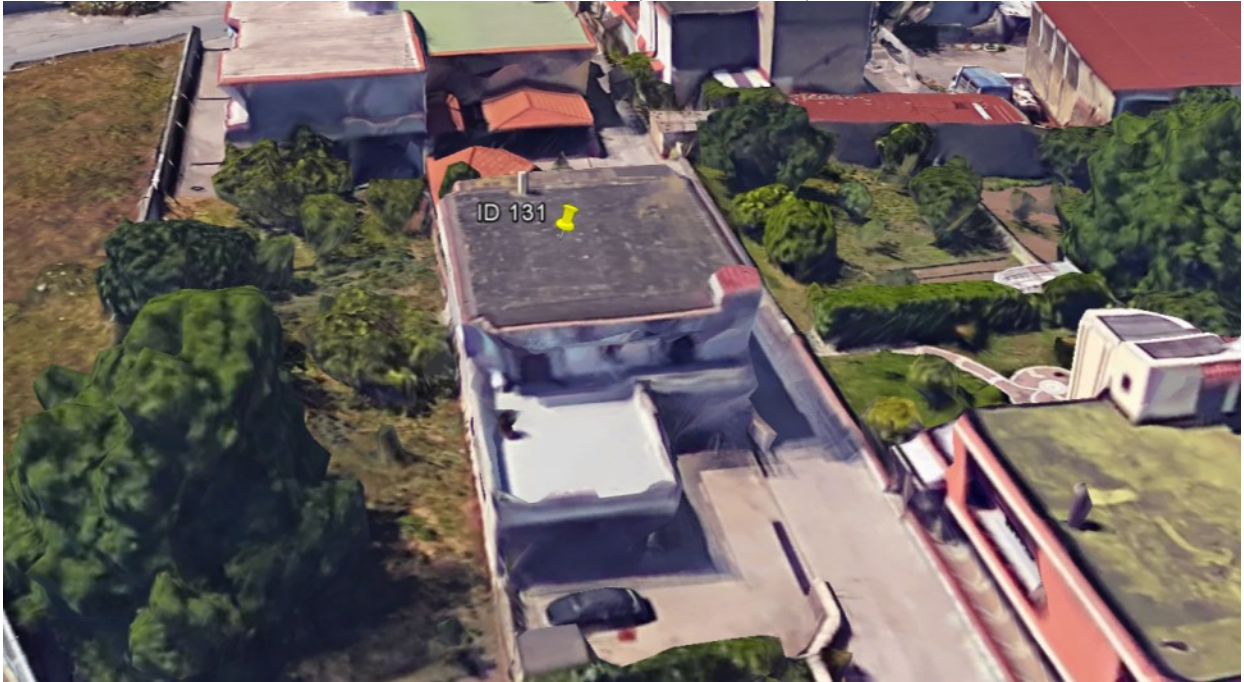
Lato 2 – SUD EST (esposto sulla strada)
