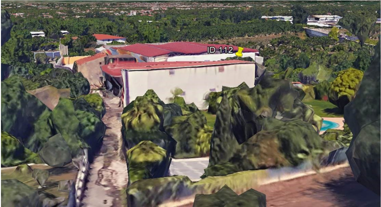
Lato 1 – Facciata SUD OVEST (esposta sulla strada)
