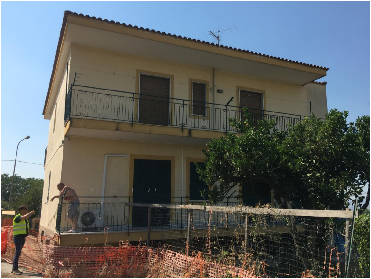
Lato 3 – SUD EST (esposto sulla strada)
