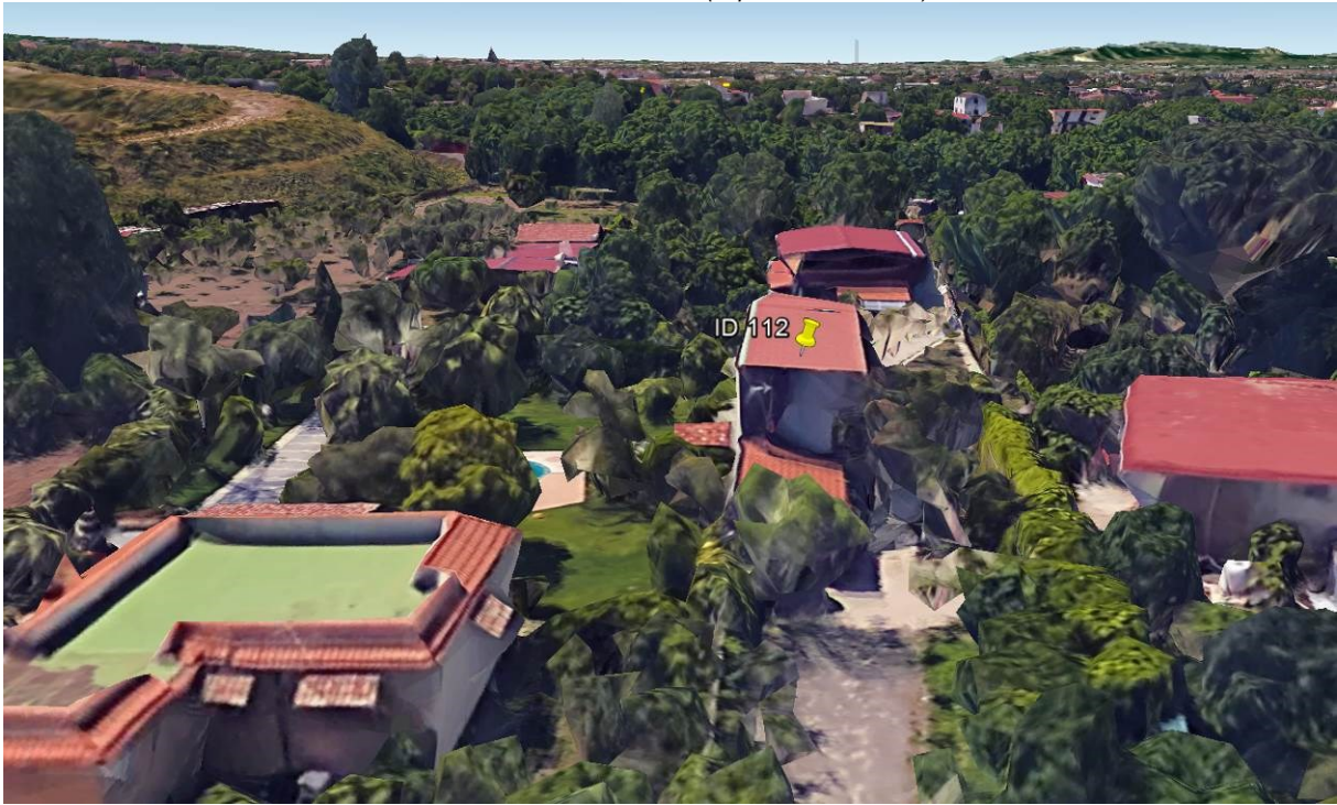
Lato 2 – Facciata SUD EST (esposta sulla strada)
