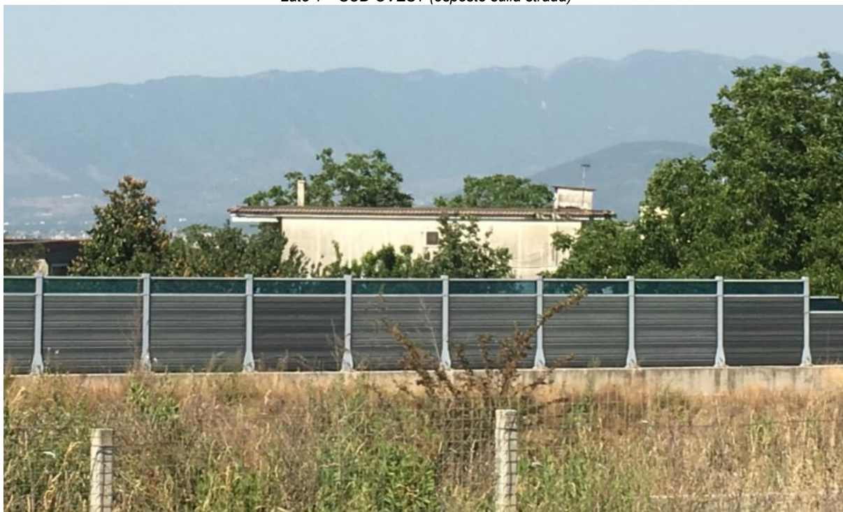
Lato 1 – SUD OVEST (esposto sulla strada)
