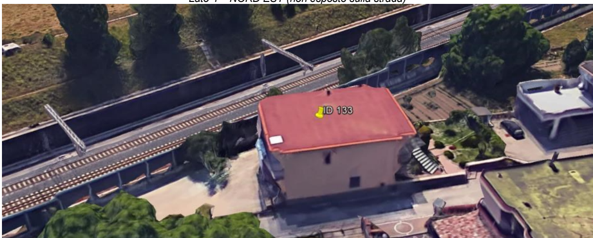
Lato 4 – NORD EST (non esposto sulla strada)
