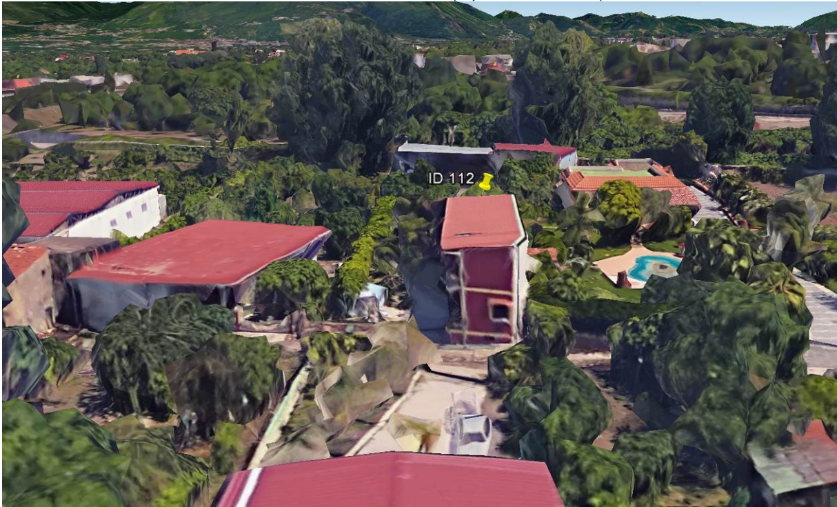
Lato 3 – Facciata NORD OVEST (esposta sullo svincolo)
