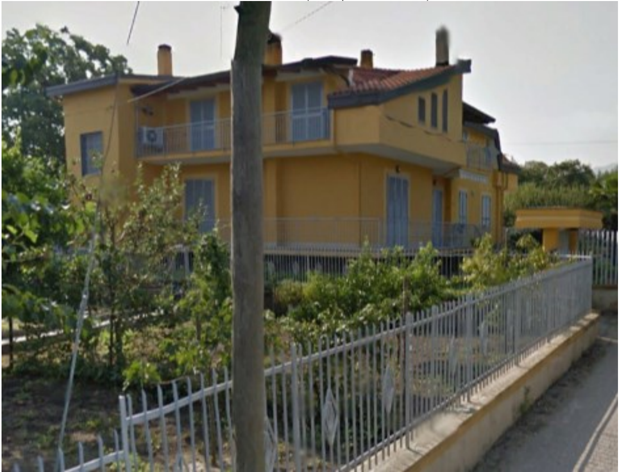
Lato 3 – facciata NORD (non esposta sulla strada)
