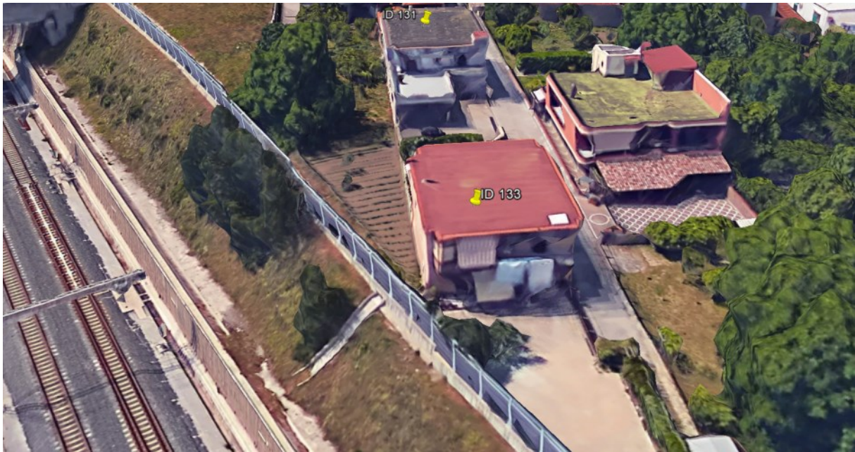
Lato 2 – SUD EST (esposto sulla strada)
