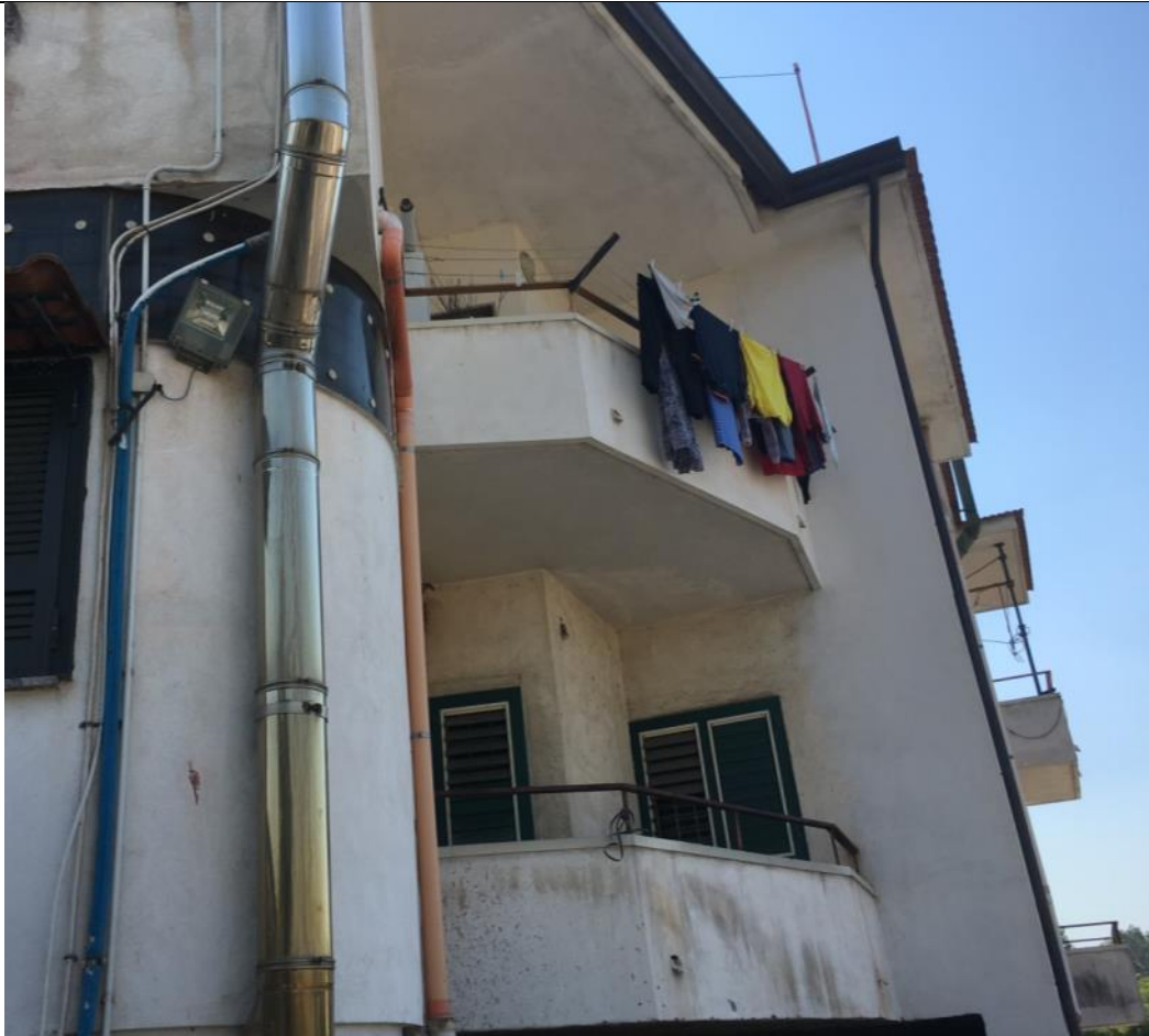
Lato NORD OVEST – dettaglio dei balconi
