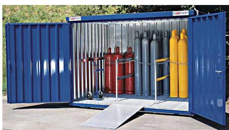
Depositare le bombole, distinte tra piene e vuote, in apposita area non interrata ed altamente arieggiata. Le bombole di ossigeno (comburente) e di sostanze infiammabili (acetilene) dovranno essere depositate separatamente e fissate in posizione eretta, evitando urti o cadute (*immagine punto 9.2.1*).
