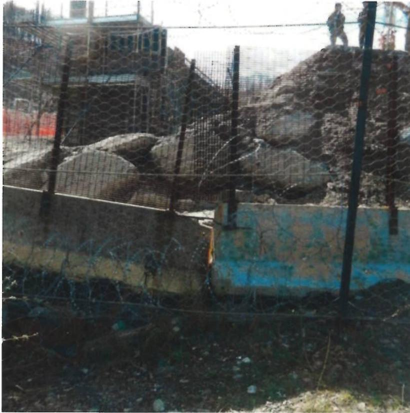
**Figura 3-30: zona di uscita dell'impluvio dalla zona di cantiere. Si nota il riporto di terra all'interno della zona di cantiere con completa copertura del piccolo corso d'acqua- primavera 2013.**
