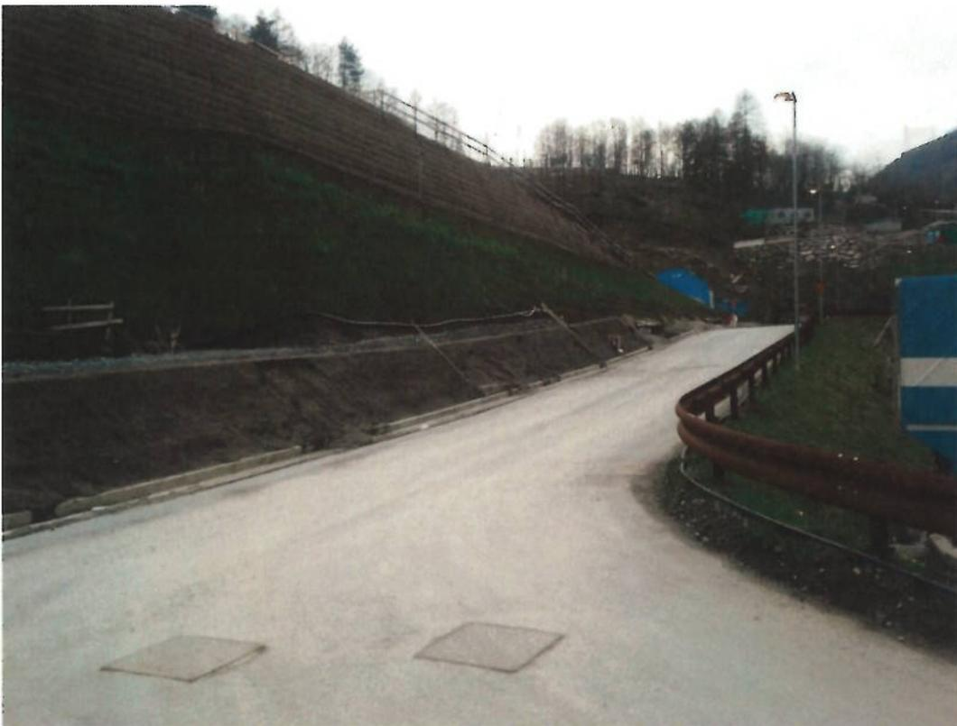
**Figura 3-53: area di cantiere con versante avanzato dall'accumulo dello smarino (primavera 2015).**
